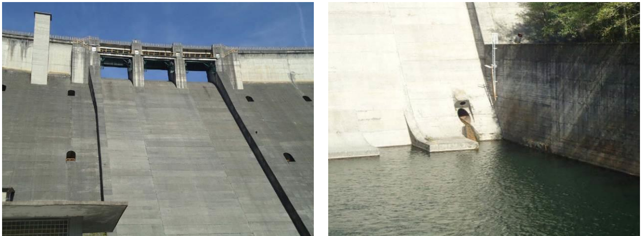
Figura 4-. Organos de desagüe de la presa de Añarbe
