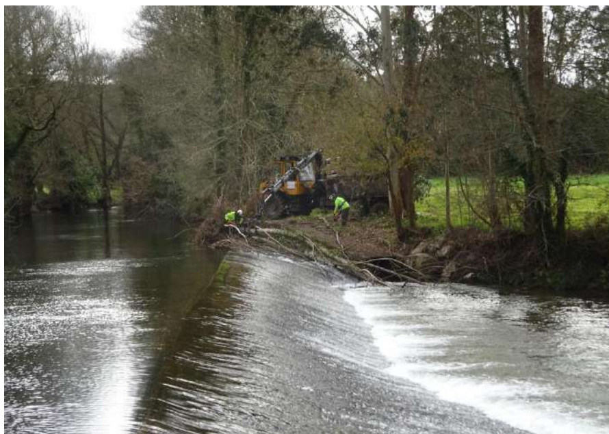
Labores de extracción de restos vegetales del cauce
