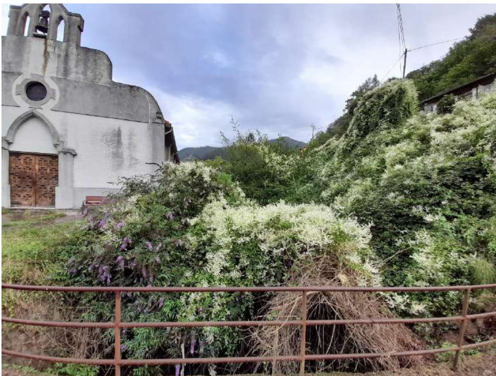
Estado del cauce del arroyo Ablaña antes de la actuación
