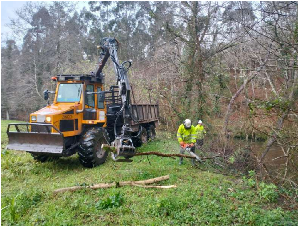
Trabajos de extracción de restos vegetales
