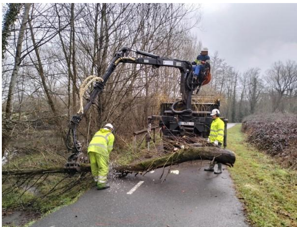
Extracción de restos vegetales del cauce
