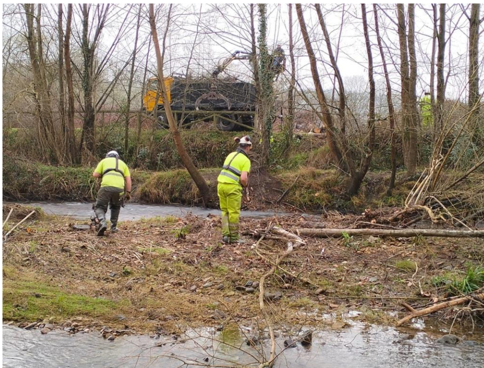
Extracción de restos vegetales del cauce
