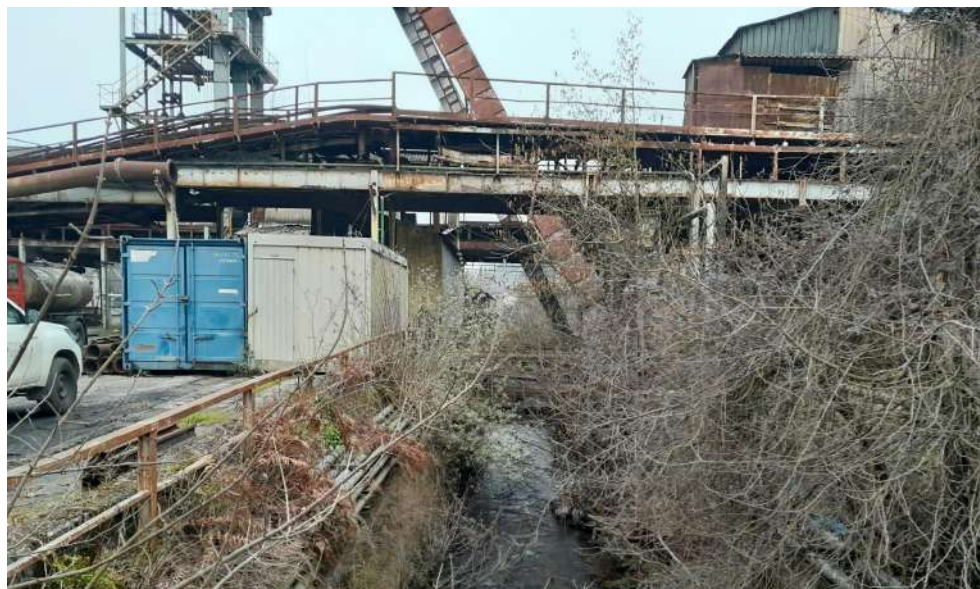
Situación antes de los trabajos a la altura del pozo Figaredo
