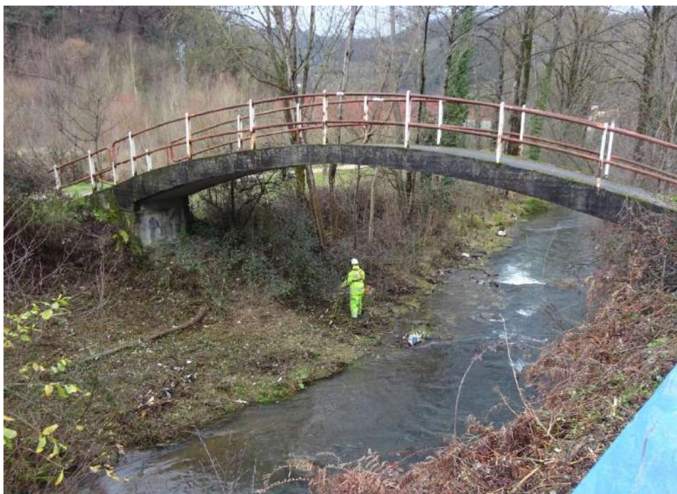
Trabajos de adecuación de la vegetación dentro del cauce
