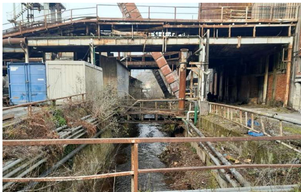
Situación después de los trabajos a la altura del pozo Figaredo
