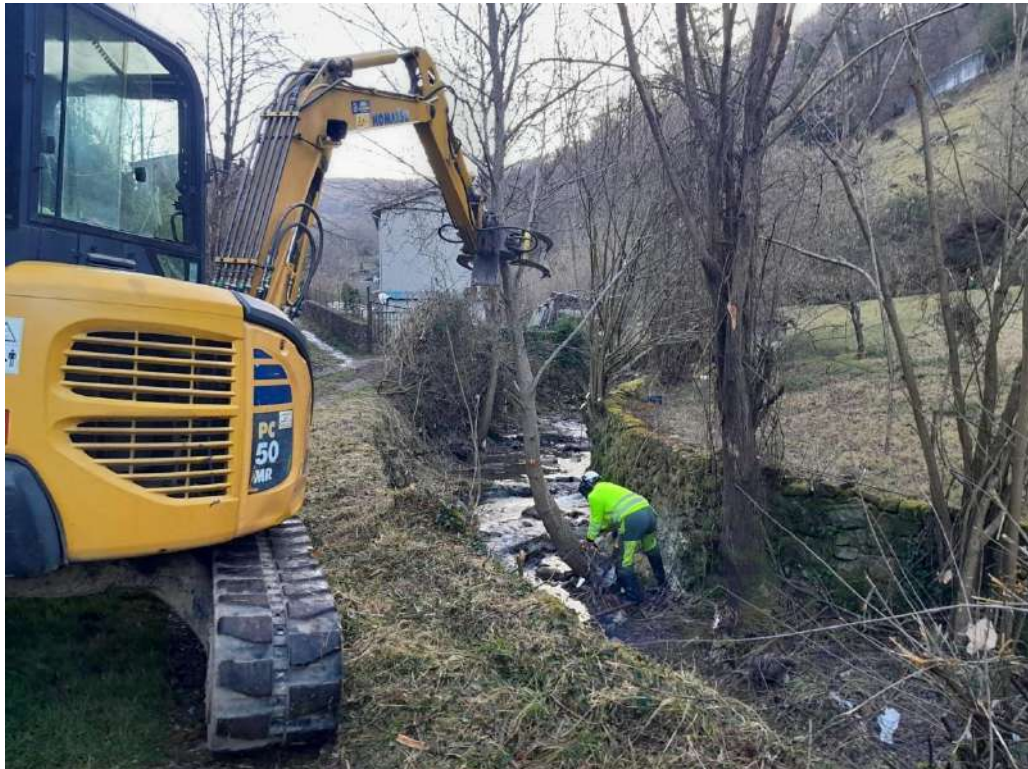
Trabajos sobre la vegetación del cauce
