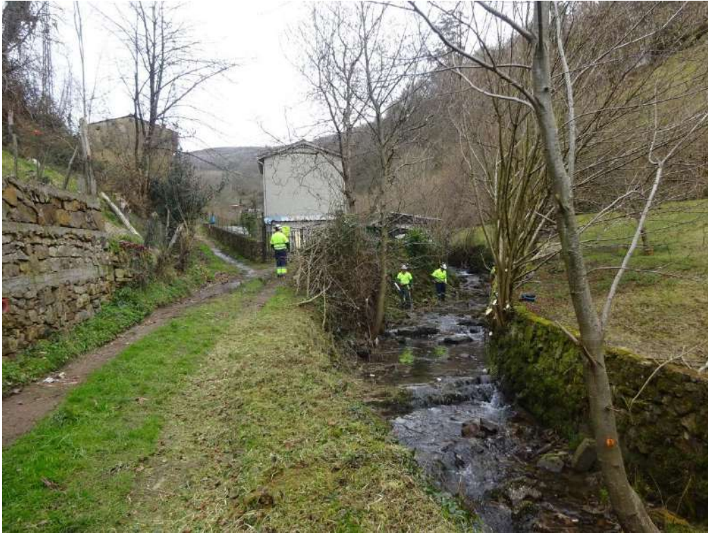
Trabajos sobre la vegetación del cauce
