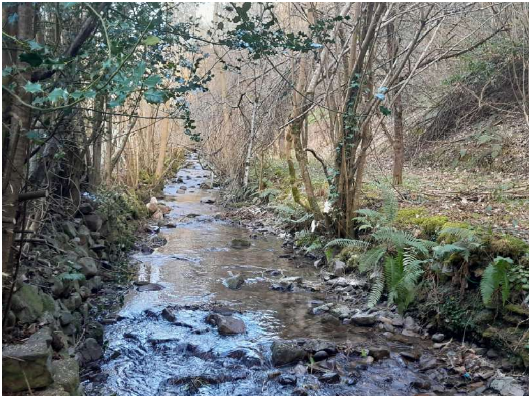
Situación final de un tramo del río San Julián tras la ejecución de trabajos
