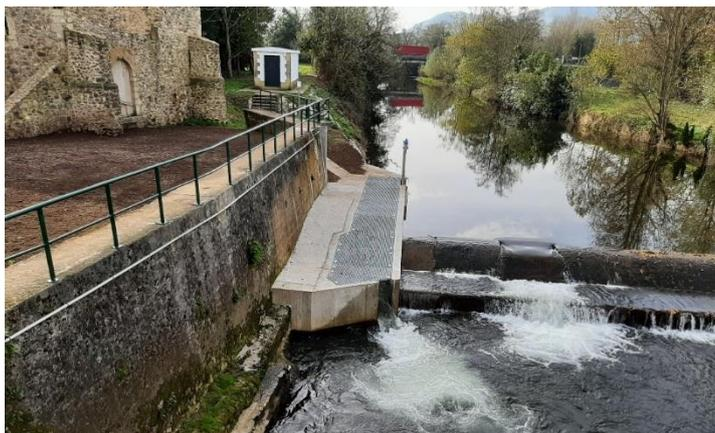
Figura 75.- Dispositivo de paso de peces en el azud de Puente Agüero
