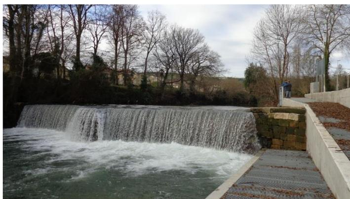
Figura 74.- Dispositivo de control de caudales y de paso de peces en la presa de Revolve en el río Miera
