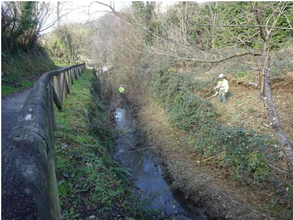
Detalle de los trabajos en el cauce del río Gafo
