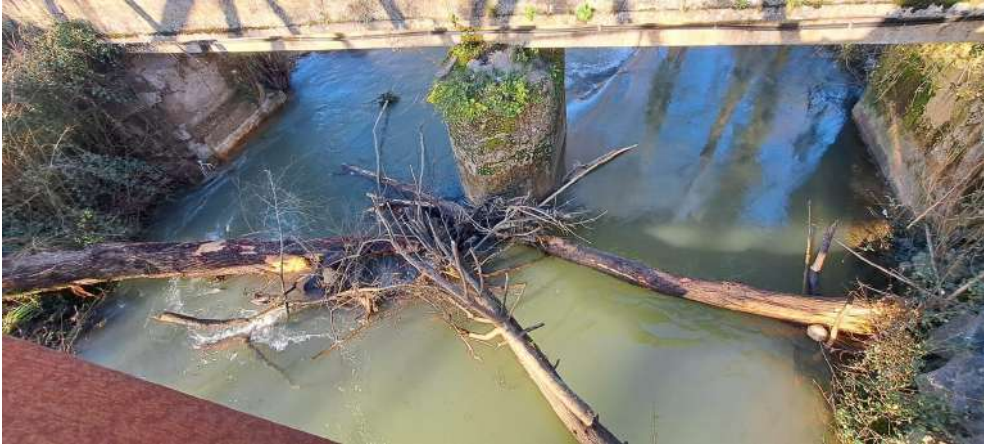
Situación del puente del Cubia antes de los trabajos
