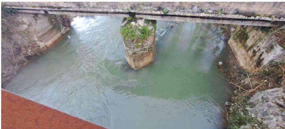
Situación del puente después de los trabajos
