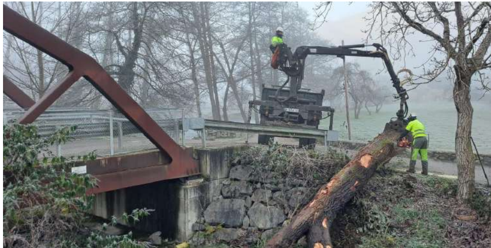
Labores de retirada de los restos vegetales del cauce
