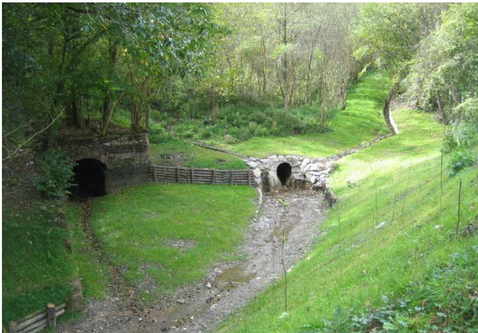
Después de los trabajos
