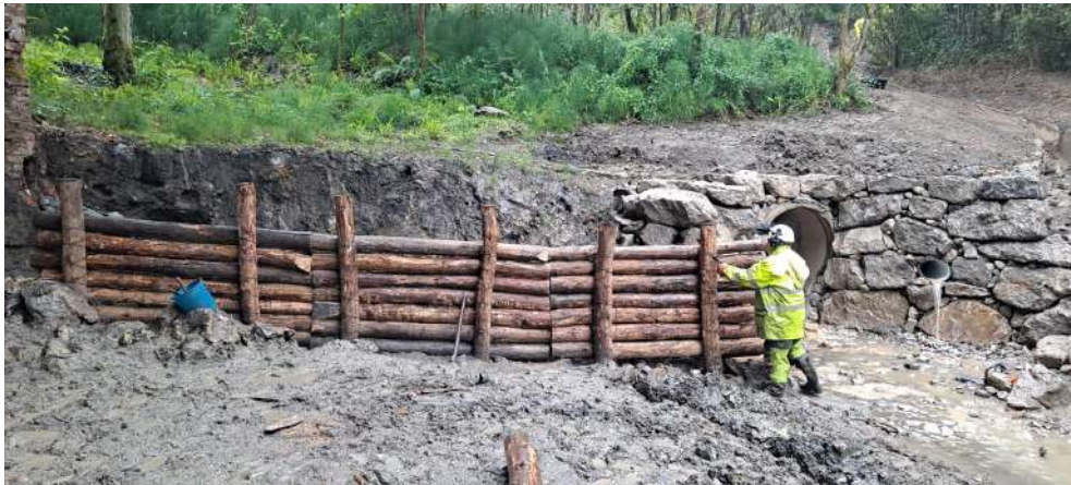
Construcción de la empalizada de madera
