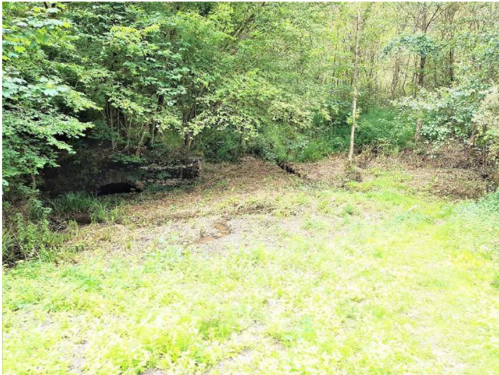
Antes de los trabajos
