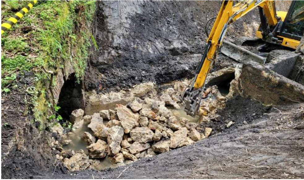
Retirada de la antigua canalización
