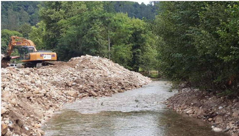
Actuación en la margen izquierda
