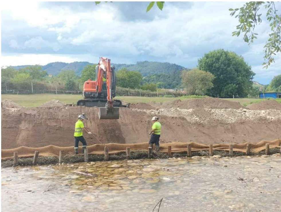
Técnicas de bioingeniería en talud restaurado
