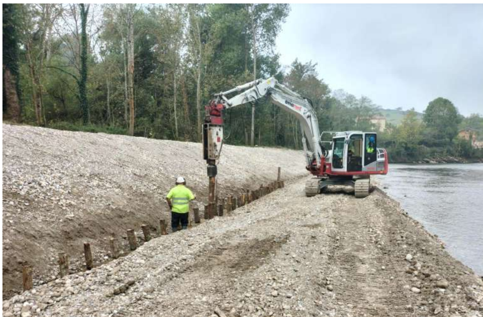
Retro y operario ejecutando técnicas de bioingeniería en talud restaurado
