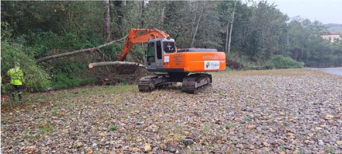
Retro y operario retirando árboles caídos
