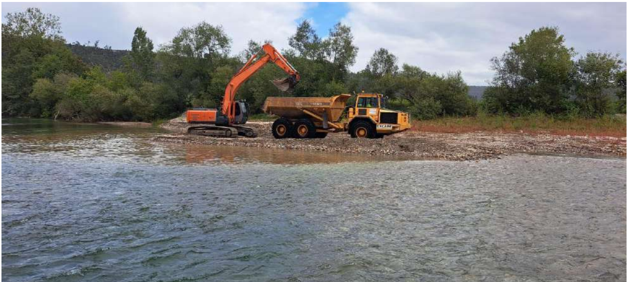
Retro cargando acarreos sobrantes en un lagarto para la reconstrucción del talud de margen izquierda
