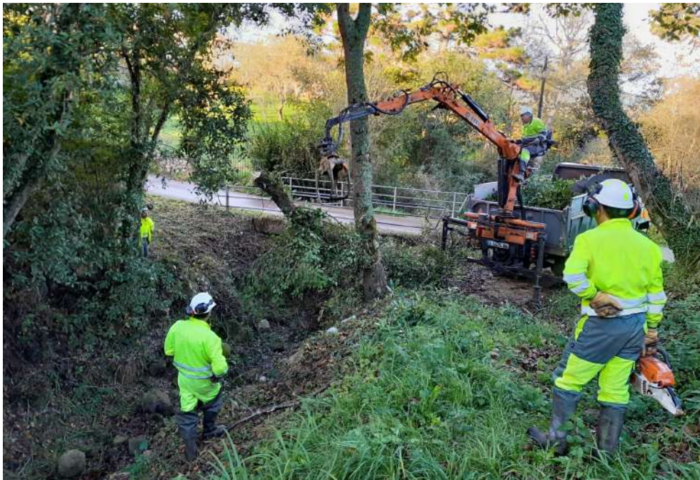
Camión autocargador retirando restos vegetales del cauce
