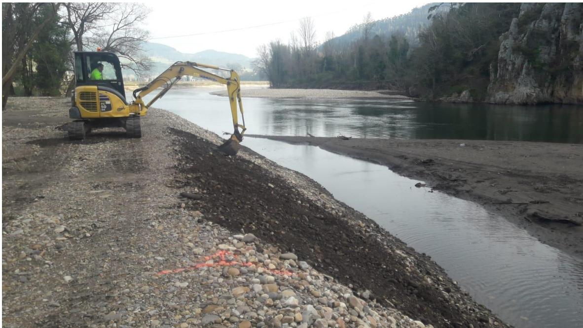
Mini-retro ejecutando bioingeniería en talud
