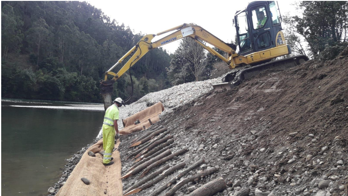
Operario y mini-retro ejecutando bioingeniería en talud
