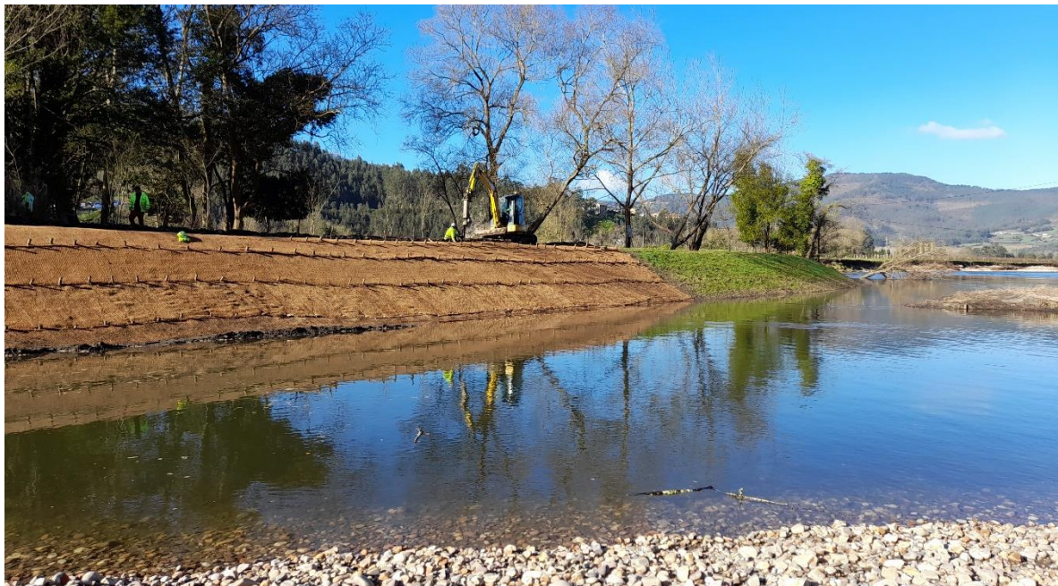
Vista de talud con bioingeniería
