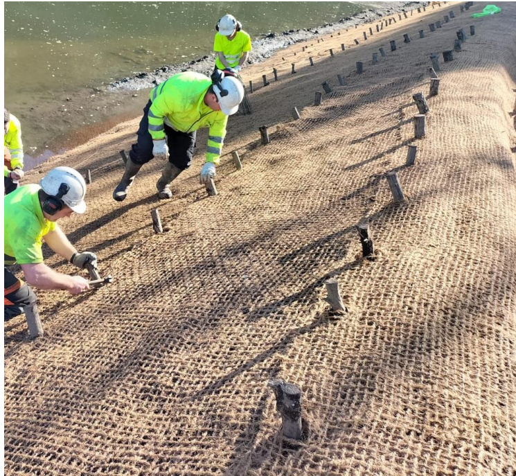
Operarios ejecutando bioingeniería en talud
