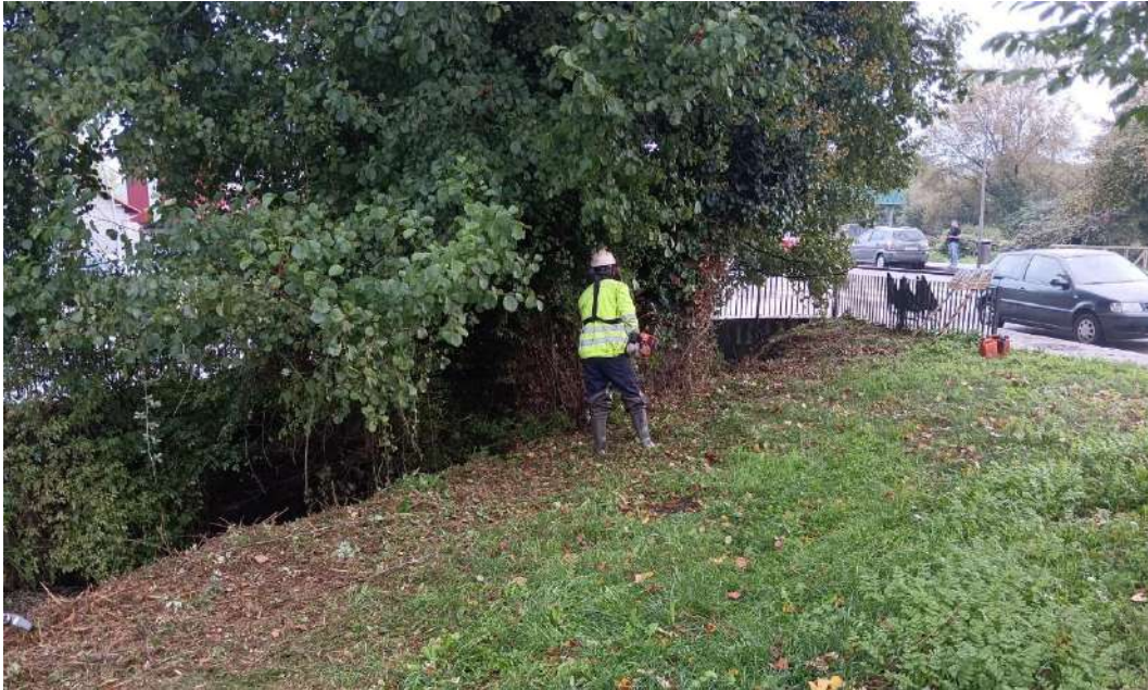
Operario desbrozando en arroyo de la Vega
