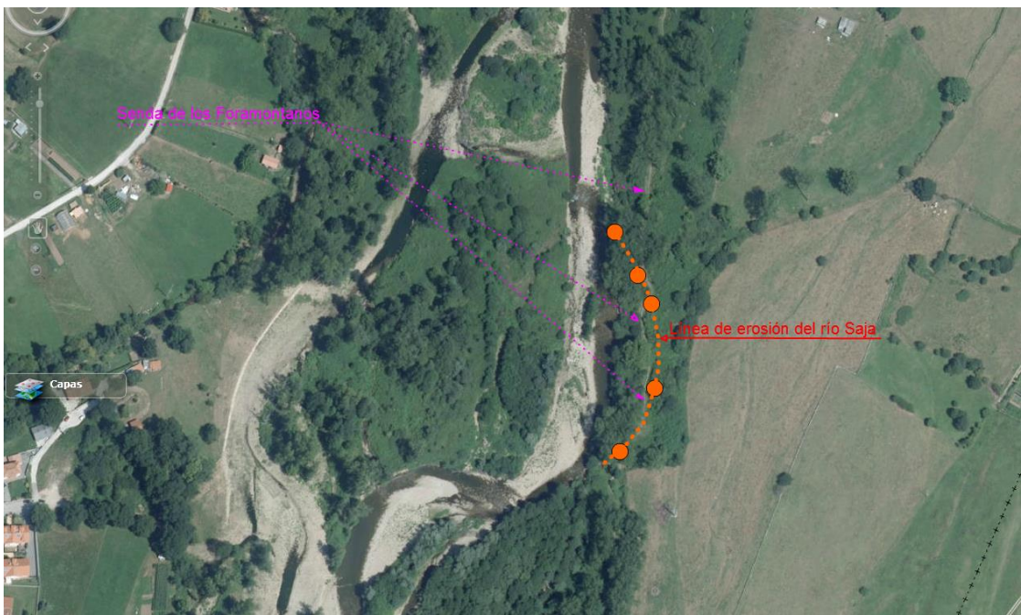
Foto 1: regresión de la margen en planta (enero de 2016) y desaparición de la senda
