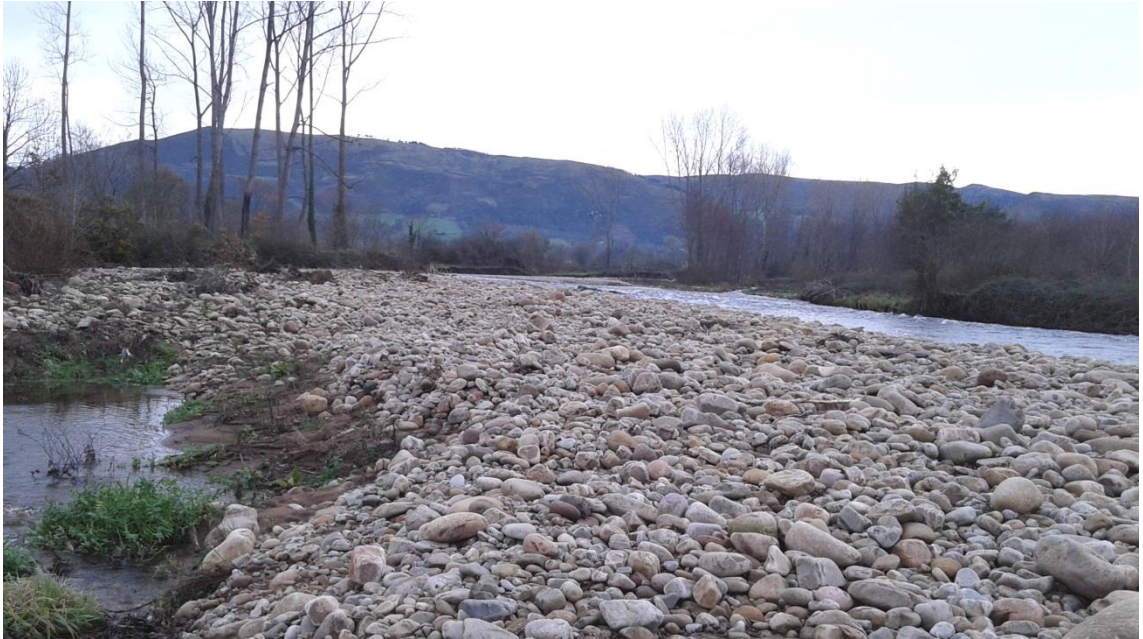
Foto 6: acarrees a retirar en margen derecha, aguas abajo de la zona erosionada
