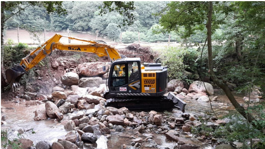
Ejecución de los trabajos: reapilado mecanizado (Bustasur)
