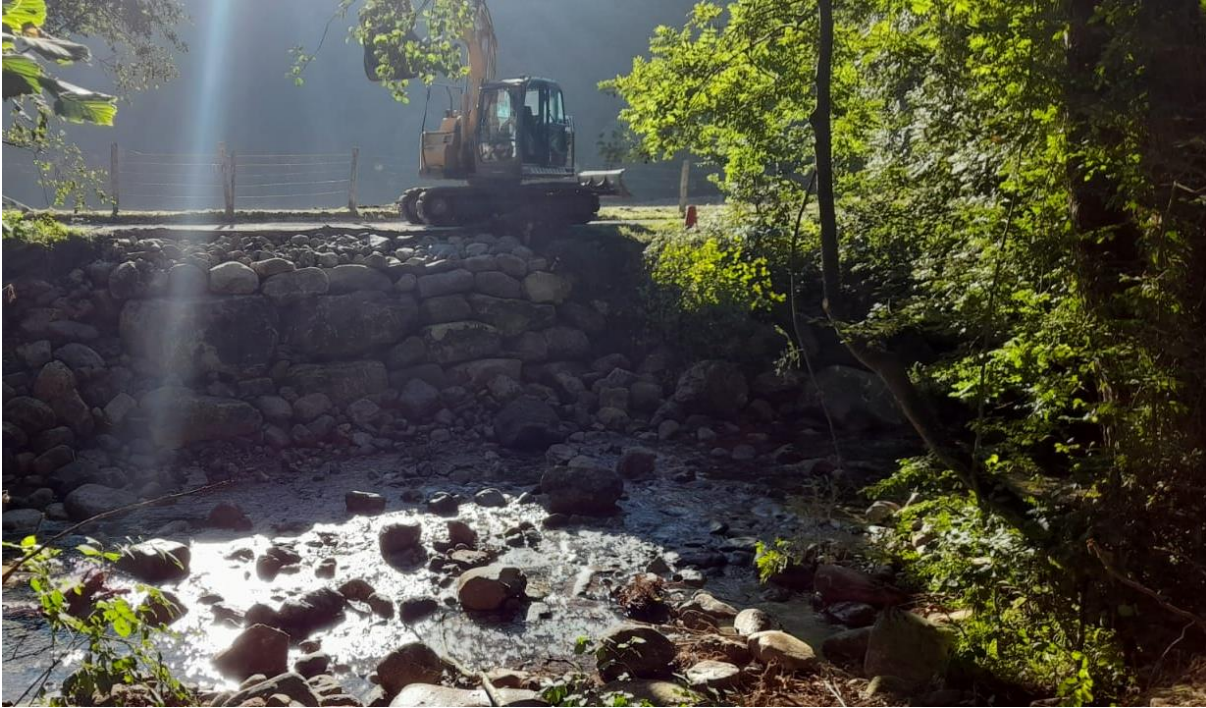
Ejecución de los trabajos (Bustasur)
