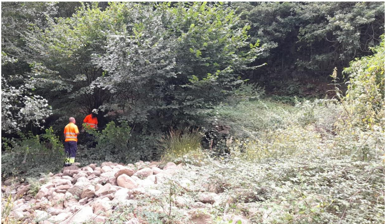
Ejecución de los trabajos: Apertura de acceso a la zona (Riluena)
