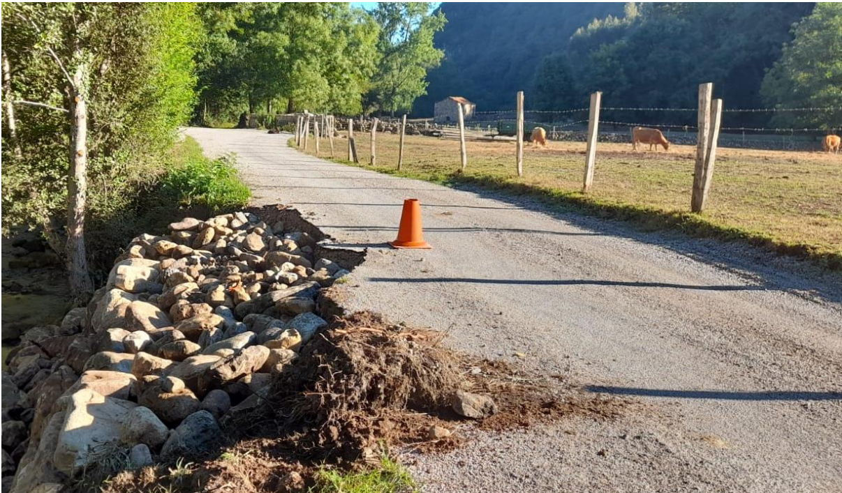
Ejecución de los trabajos: rehabilitación del acceso rodado (Bustasur)
