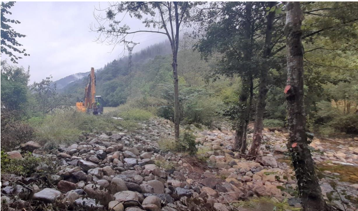
Ejecución de los trabajos: reapijado mecanizado (Riluena)
