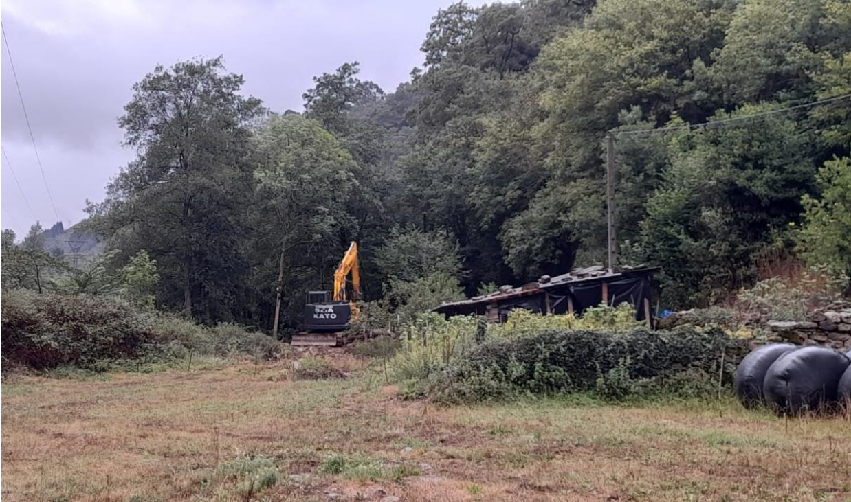
Ejecución de los trabajos: reapijado mecanizado (Riluena)
