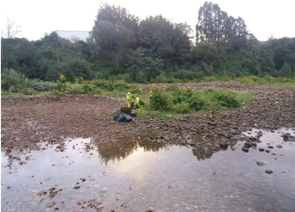
Ejecución de los trabajos: Eliminación de especies invasoras.
