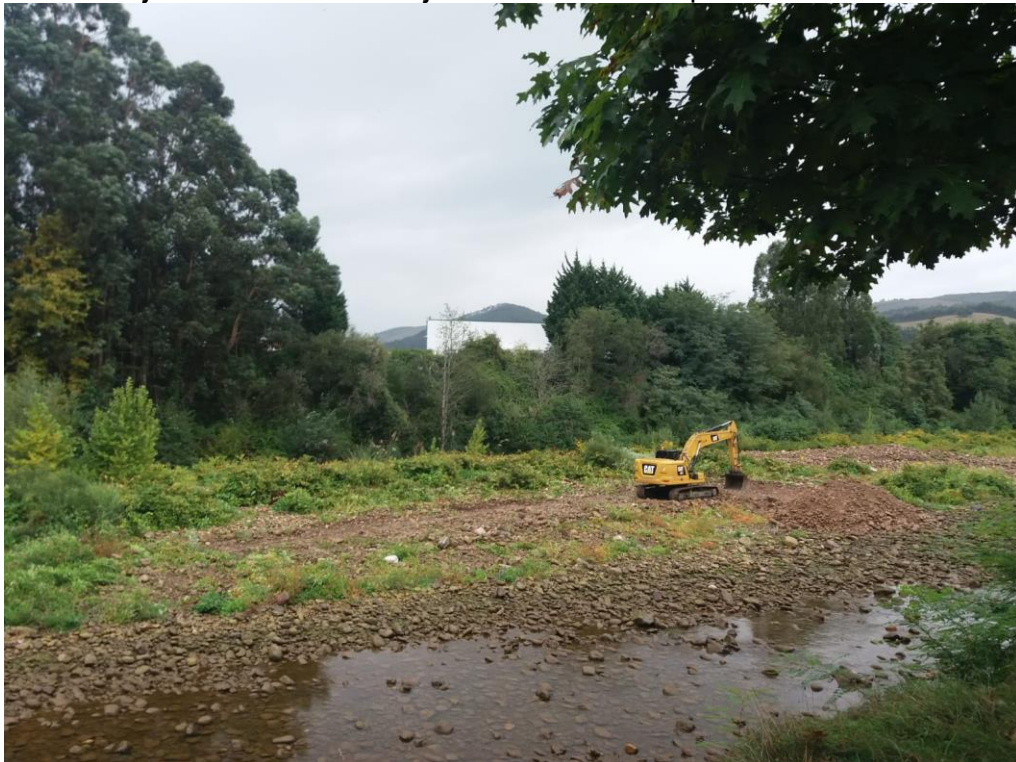
Ejecución de los trabajos: Inicio de los trabajos.
