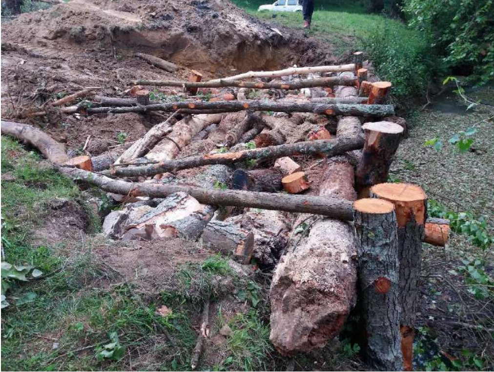
Durante: Técnicas de bioingeniería. Construcción de la empalizada vegetal
