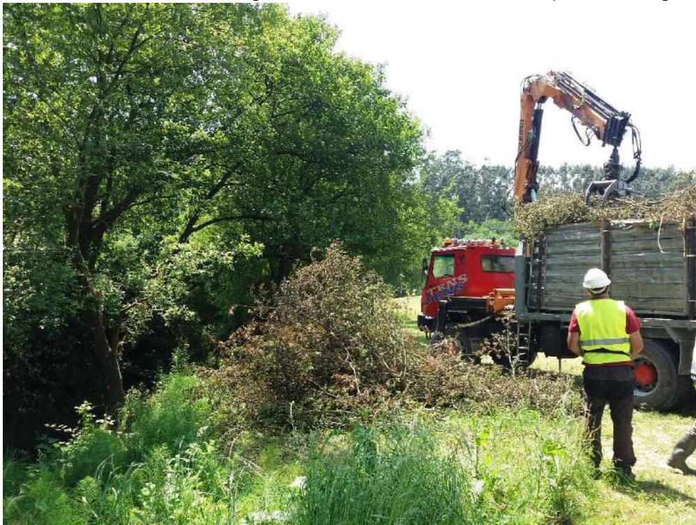
Durante: Extracción mecanizada de restos vegetales
