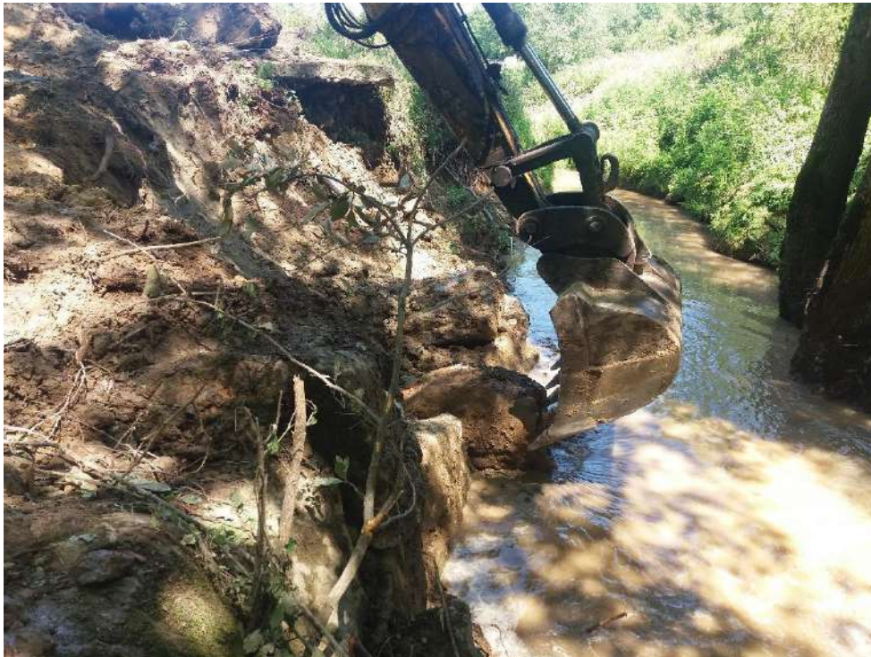
Durante: Colocación de la escollera de protección
