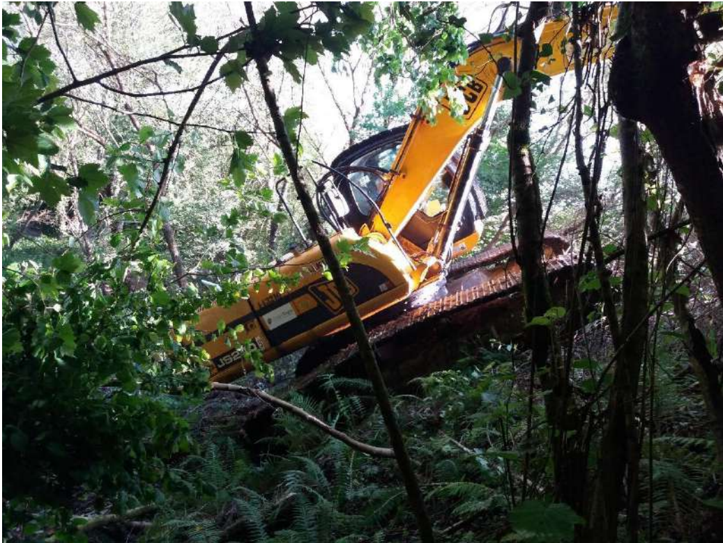
Durante: Apertura de acceso al cauce
