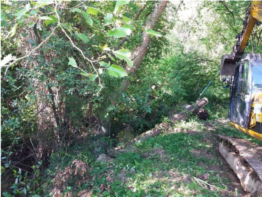
Durante: Extracción mecanizada de troncos caídos
