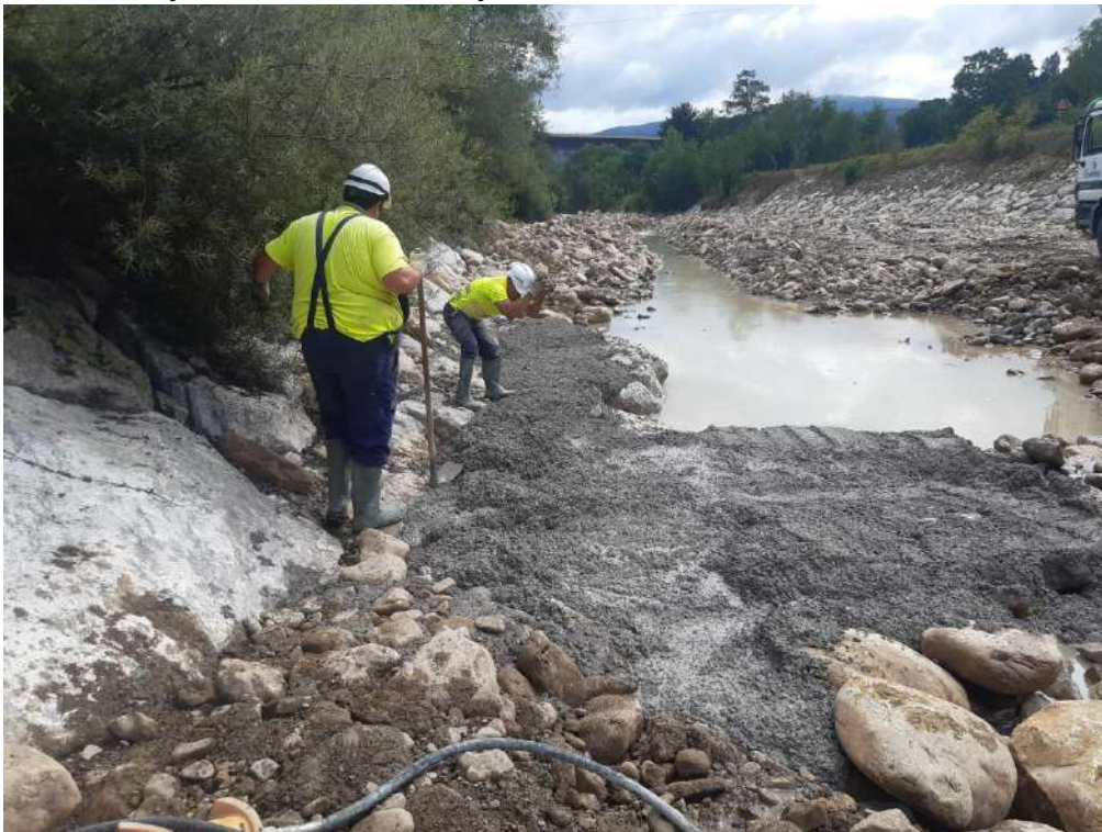
Ejecución de los trabajos: Hormigonado de la prolongación de las rampas
