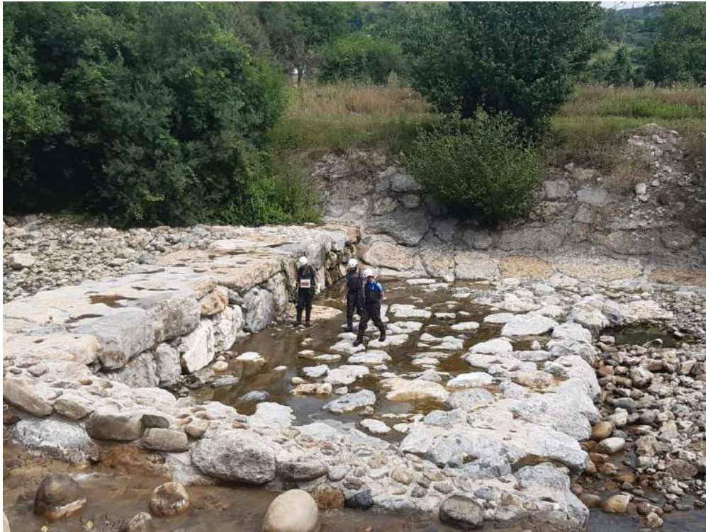
Ejecución de los trabajos: Realización de pesa eléctrica
