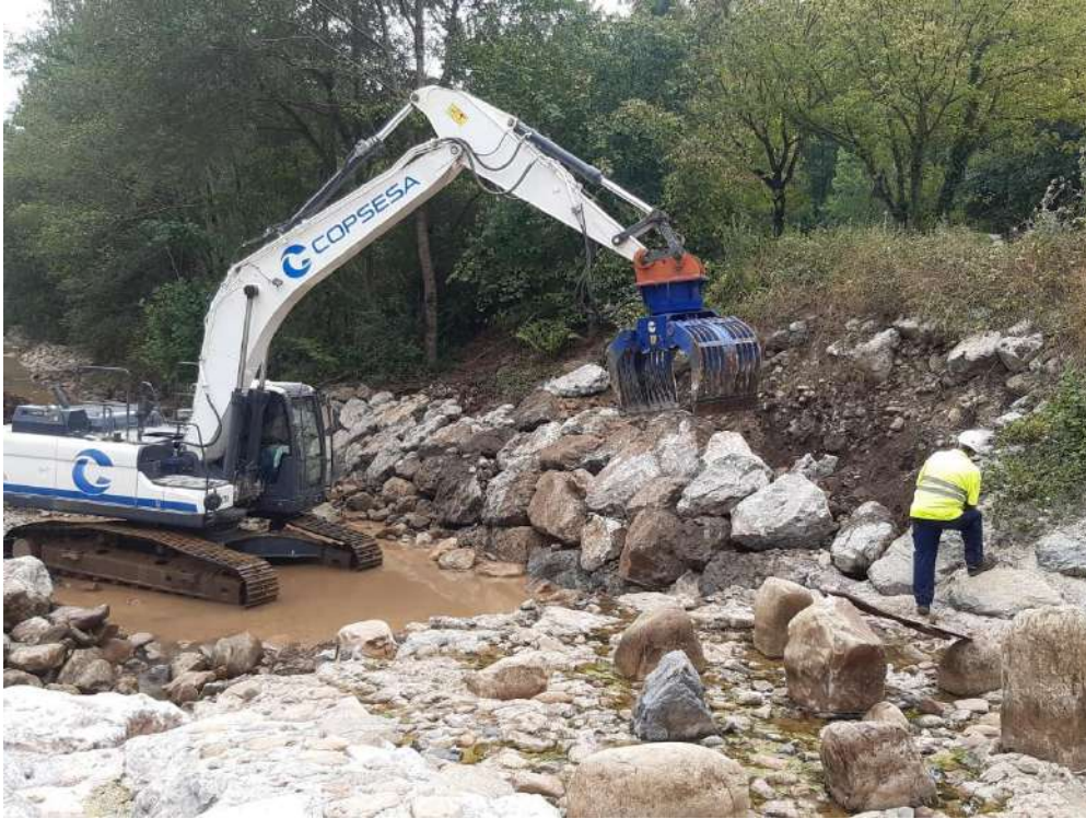
Ejecución de los trabajos: Reconstrucción de escollera
