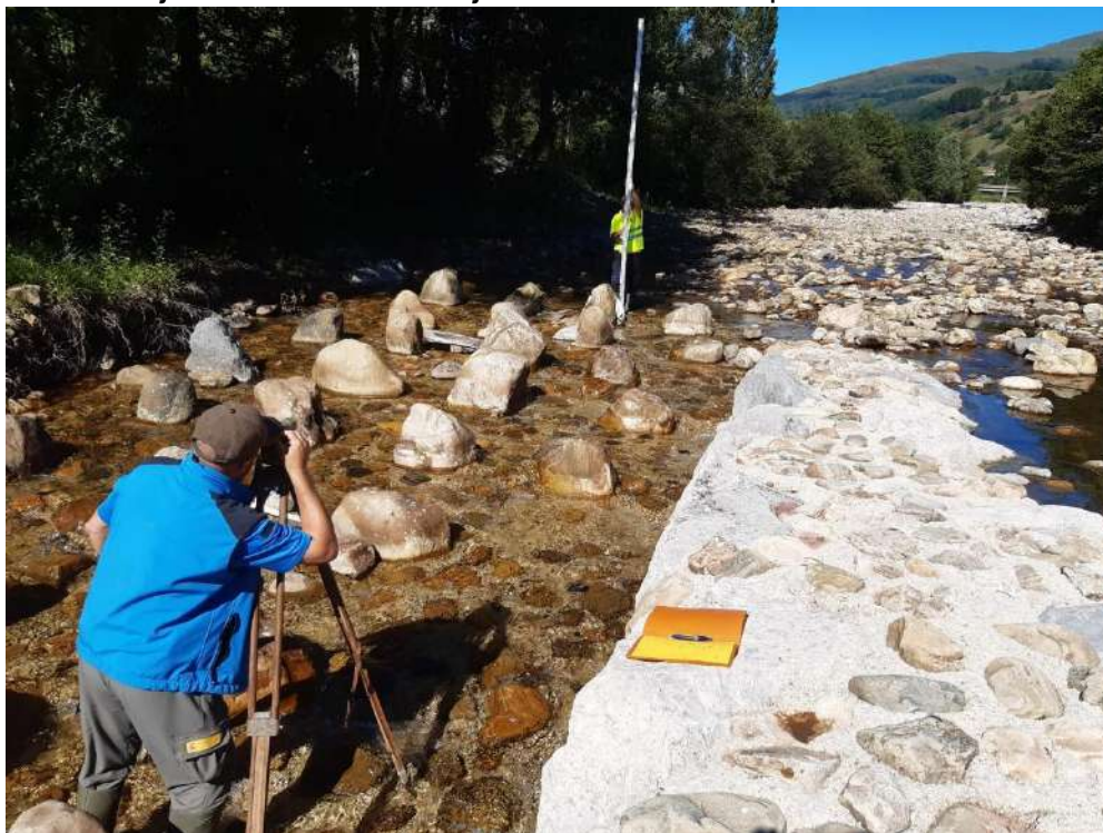
Ejecución de los trabajos: Trabajos de replanteo
