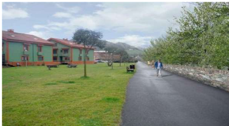
Muro de protección frente avenidas
