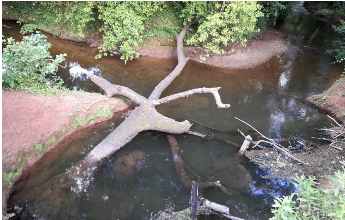
Árbol caído que tapona el cauce
