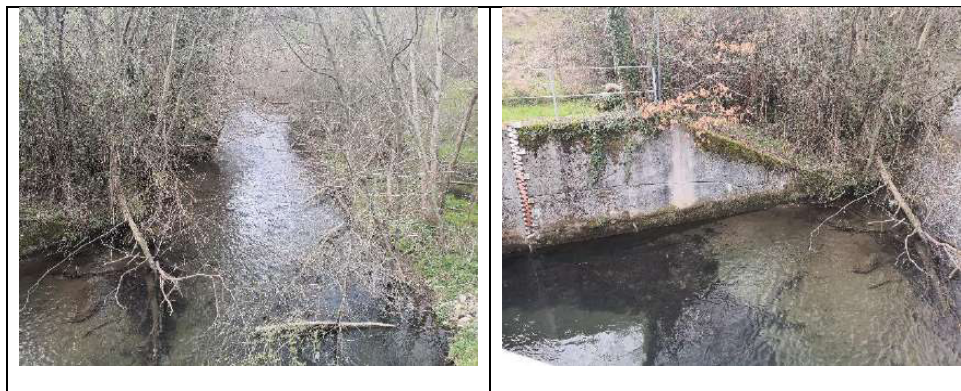
Imagen 2: Imagen del margen derecho del embalse por donde se concentra la circulación del caudal del río.
