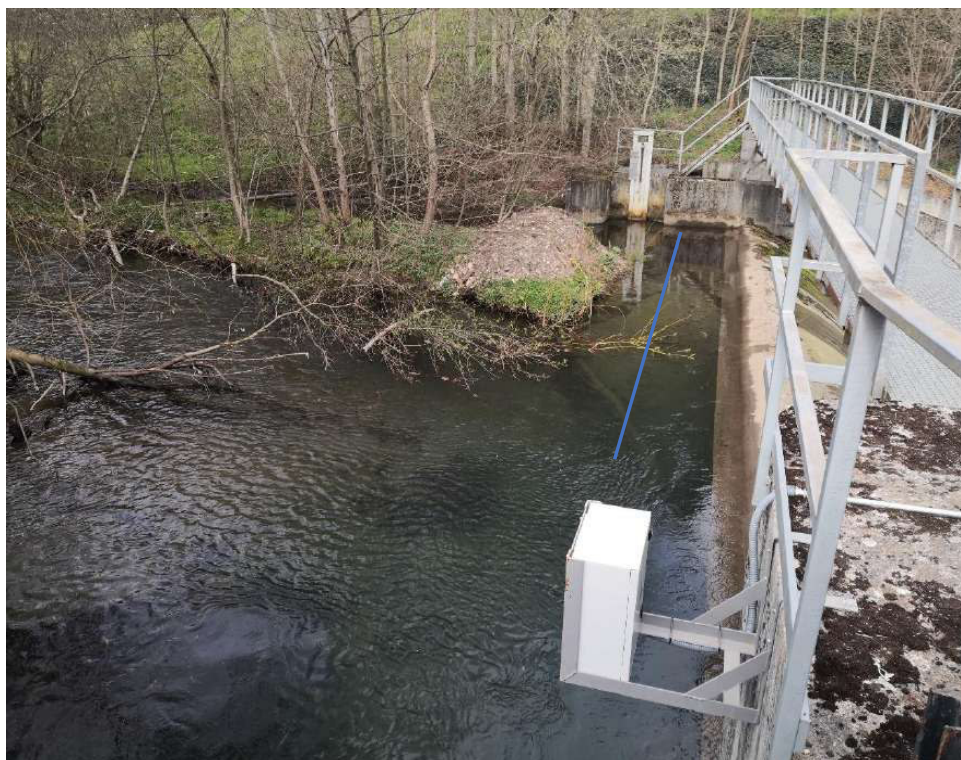
Imagen 3: Imagen de la zona en el que se realiza la retirada manual del material acumulado, para mantener comunicados los dos extremos del azud. La captación de entrada de la escalera de peces se localiza al fondo de la imagen
