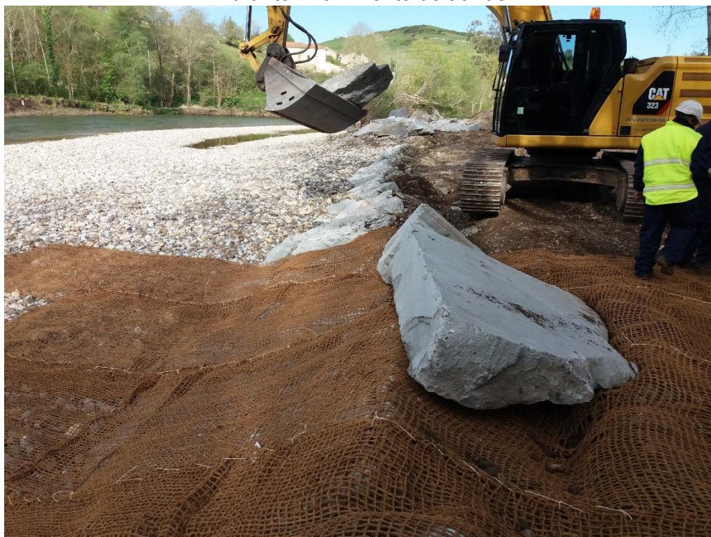
Durante: Colocación del muro de escollera con malla de coco
