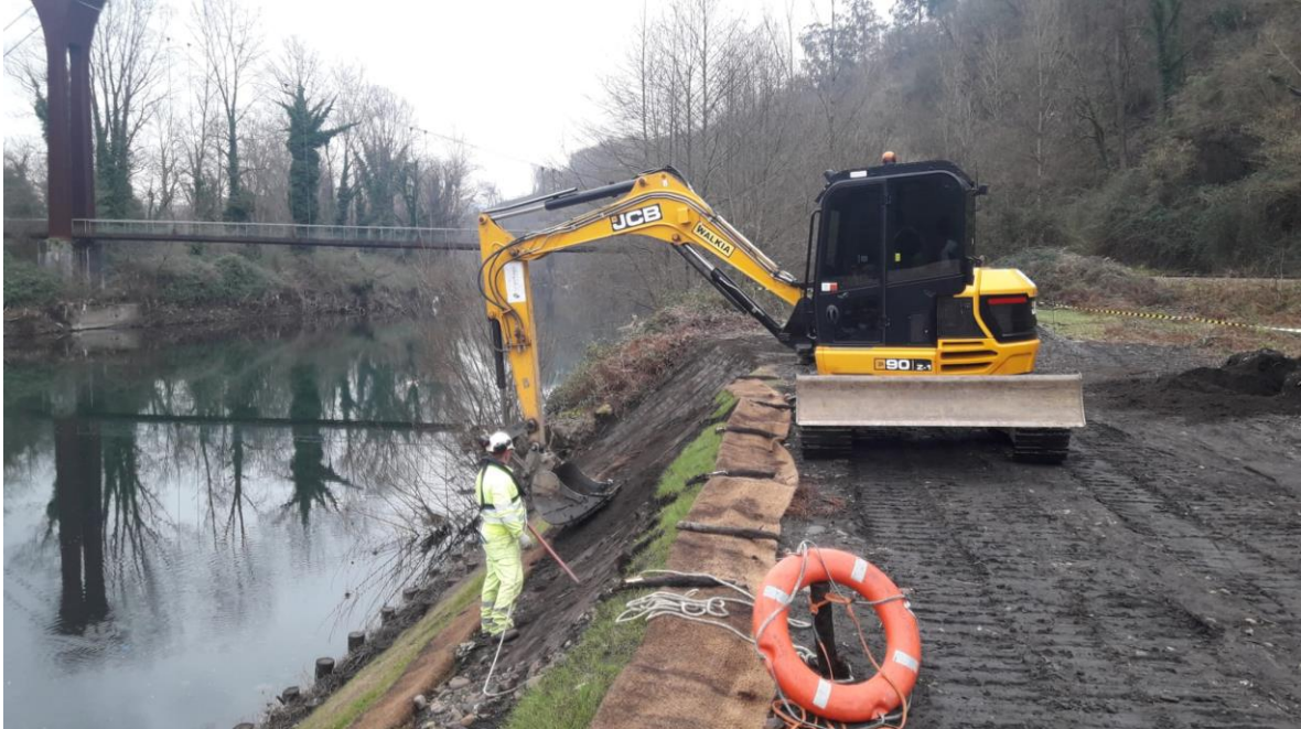
Mini-retro y operación ejecutando bioingeniería en talud
