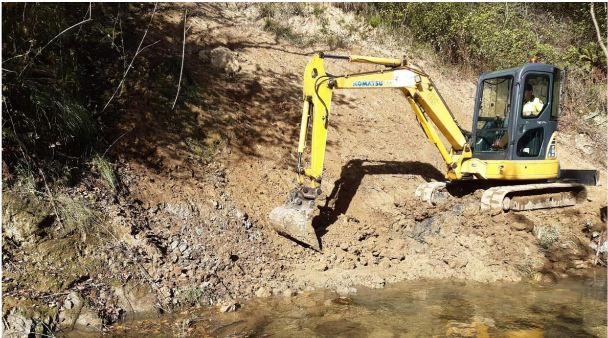
Mini retro recuperando sección del lecho y acondicionando la margen izquierda
