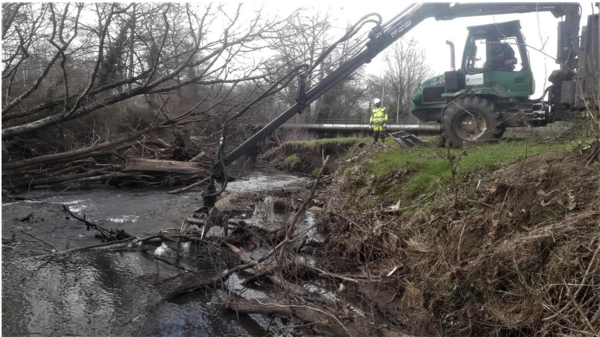
Operarios y autocargador retirando árbol del cauce
