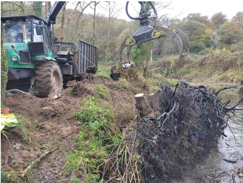
Autocargador retirando restos vegetales
