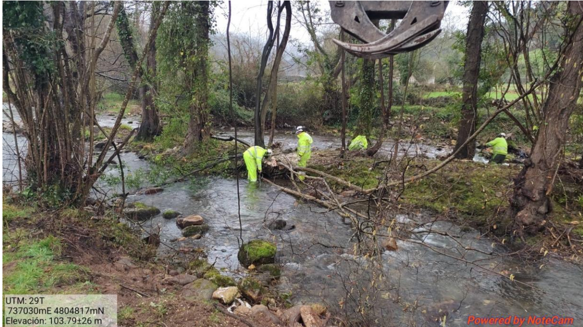
Operarios retirando restos vegetales del cauce
