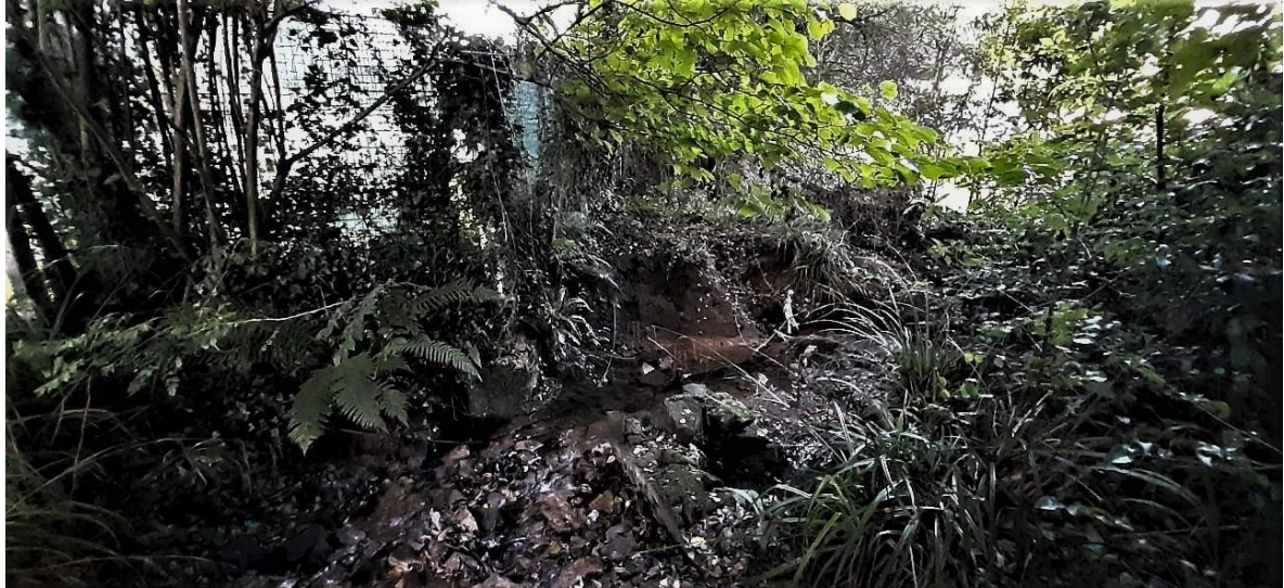
Antes de la retirada del azud en río Pillarno en Bárzanas
