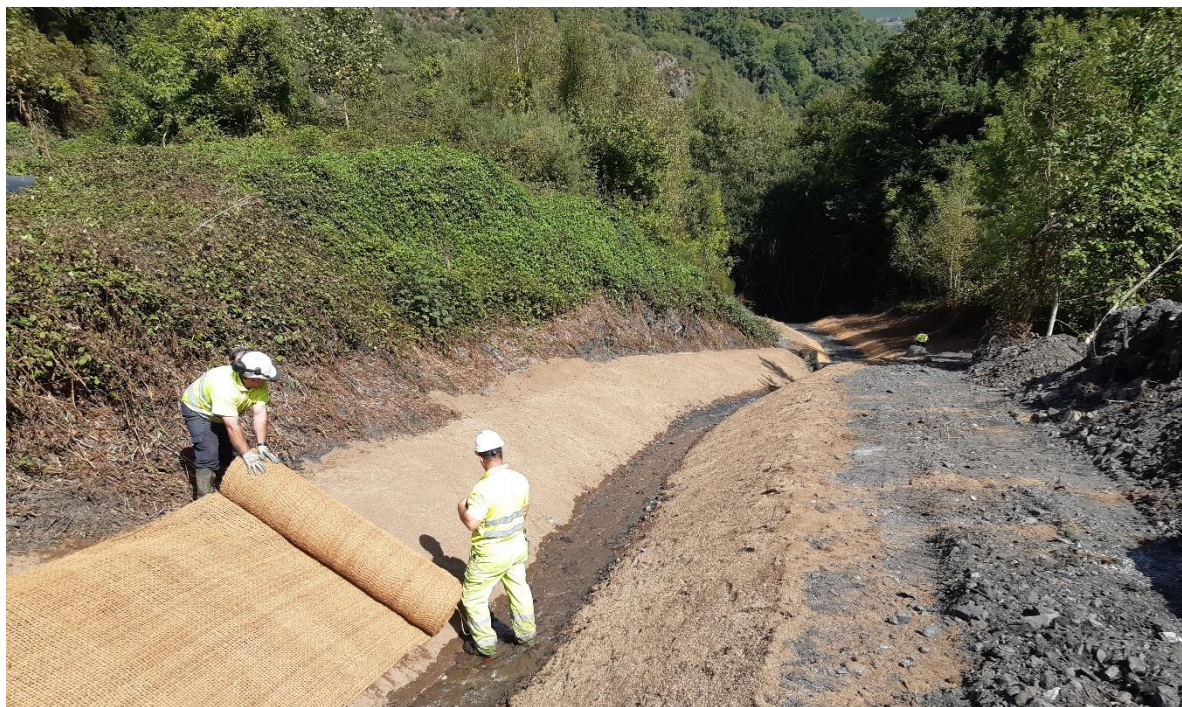
Operarios extendiendo malla de coco para ejecutar bioingeniería
