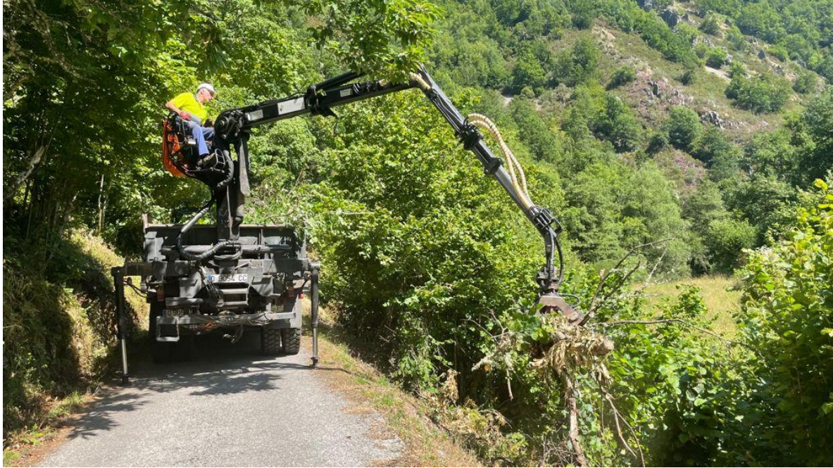
Carroceta retirando restos vegetales del cauce
