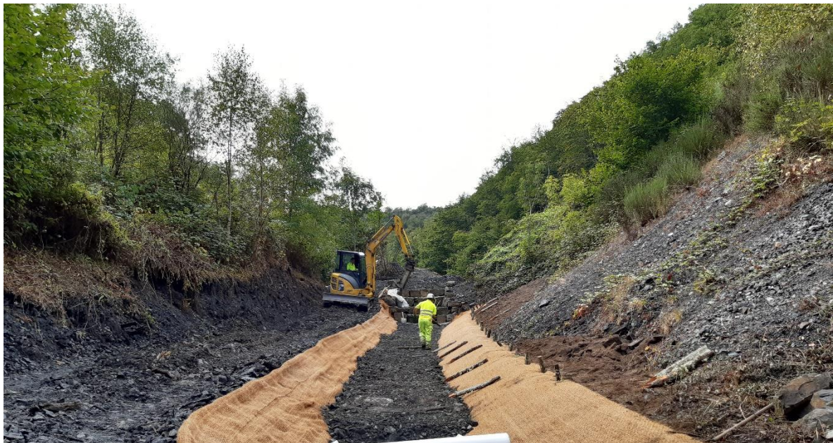
Mini-retro y operario ejecutando bioingeniería
