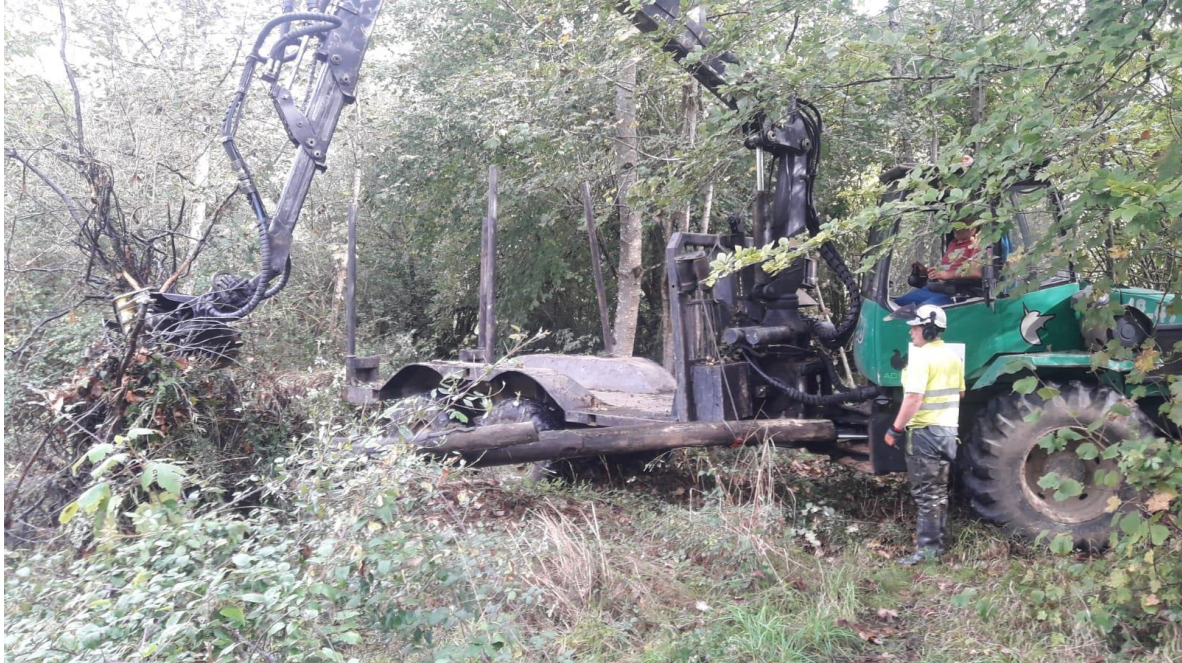
Autocargador retirando restos vegetales del cauce
