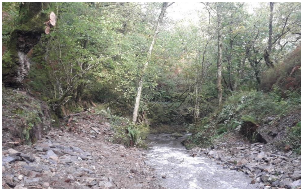
Demolición del azud en la regata Itzazola en Goizueta (después de la actuación)
