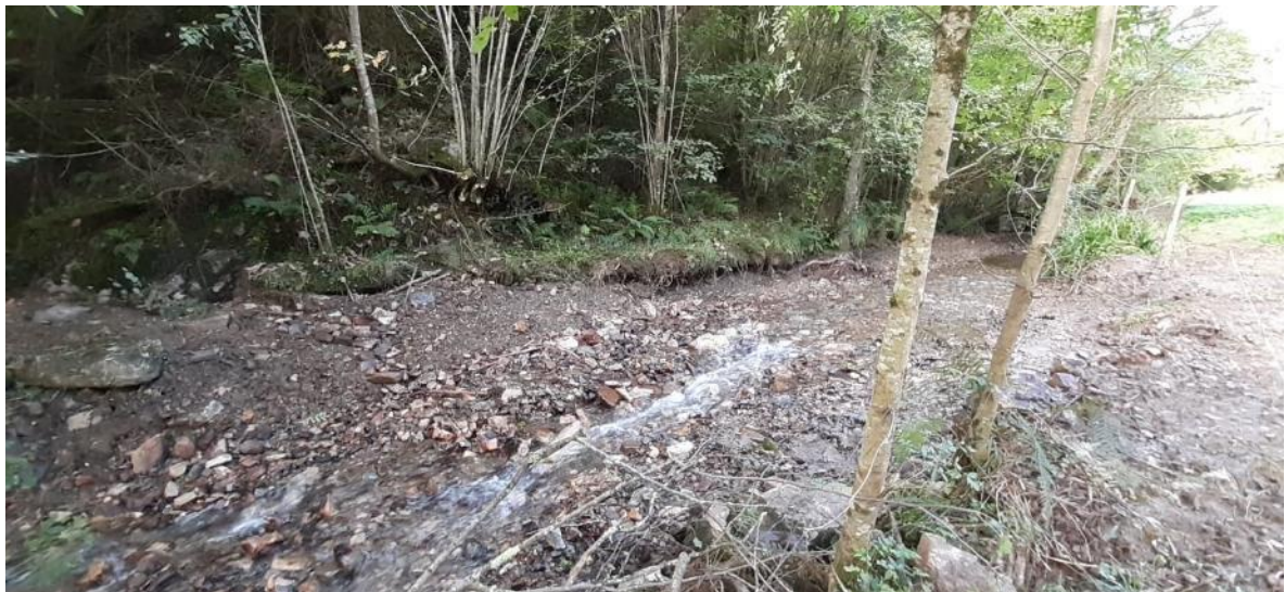
Antes de retirada del azud en el río Camuño en Allence (2)
