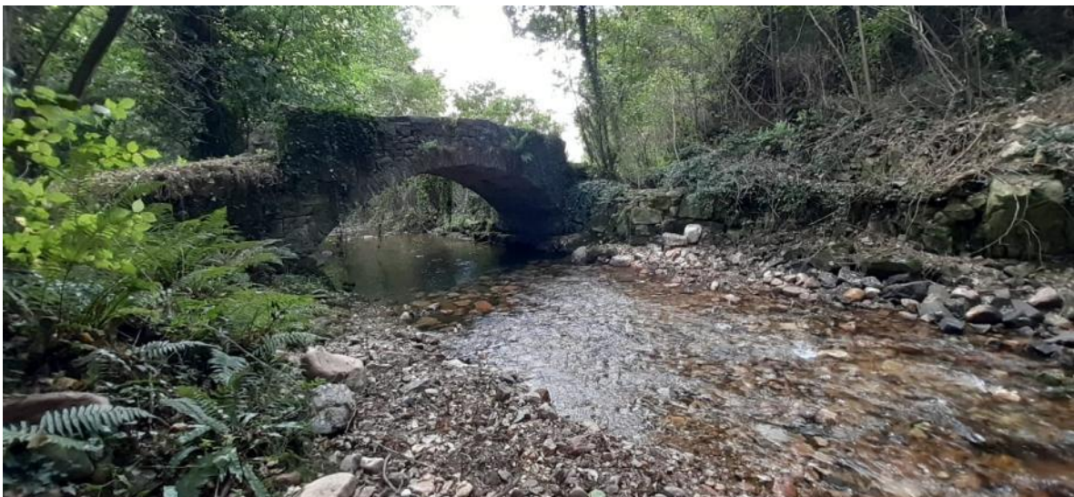
Después de la retirada del azud en el río Nonaya en Casazorrina
