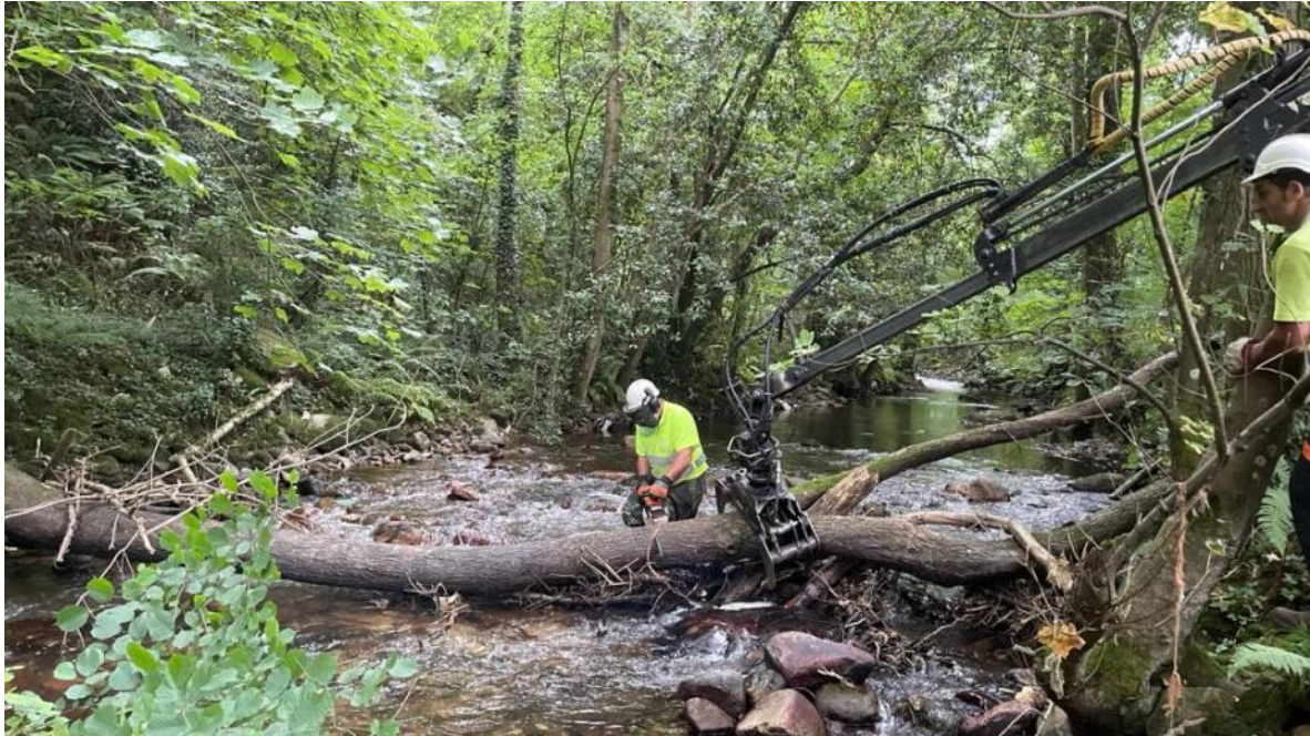
Operario cortando árbol caído para sacarlo del río
