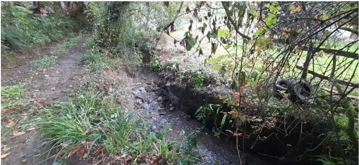
Después de la retirada del azud en el arroyo Pastrín en Linares
