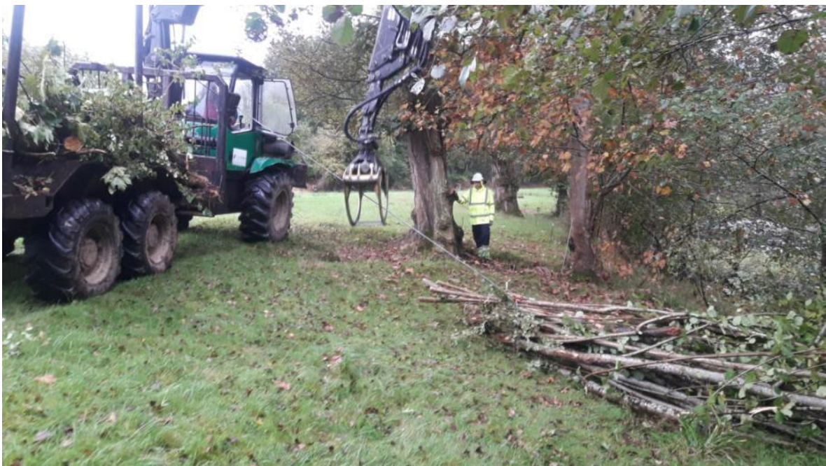
Autocargador retirando restos vegetales
