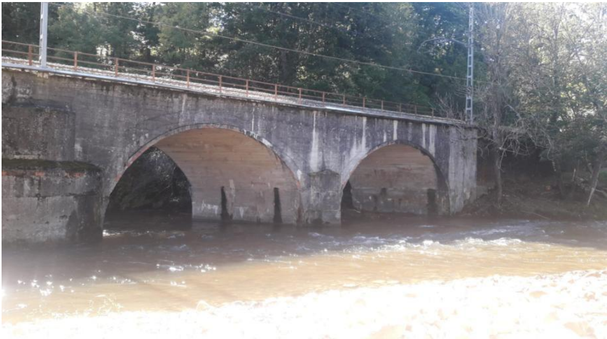
Puente sin restos vegetales acumulados después de la actuación
