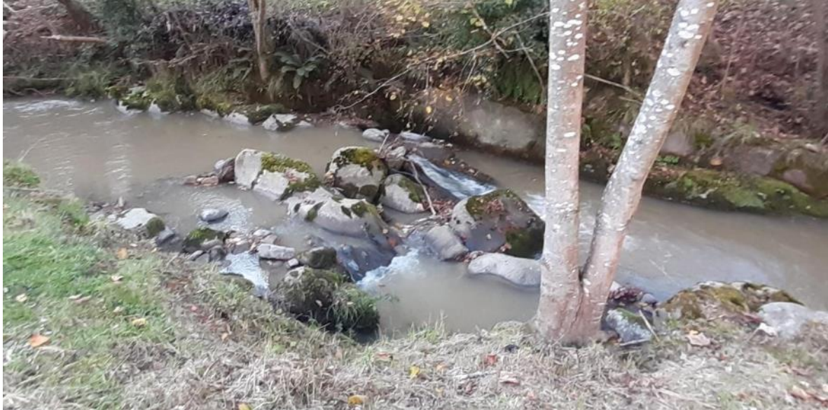
Antes de la retirada del azud del río Tendi en Caldevilla (3)
