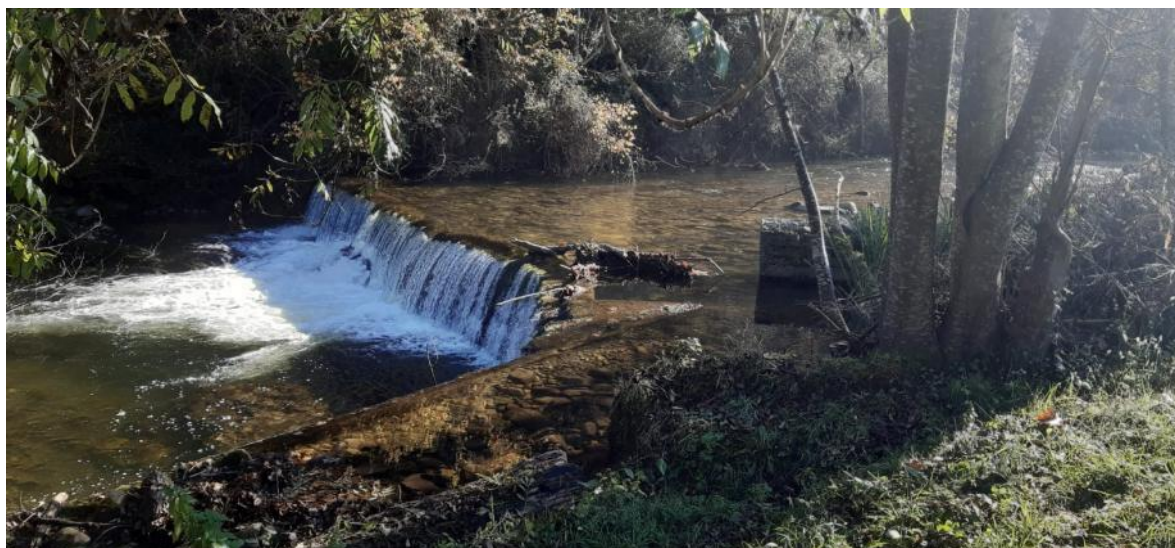
Antes de la demolición parcial del azud del río Espinaredo en Lozana
