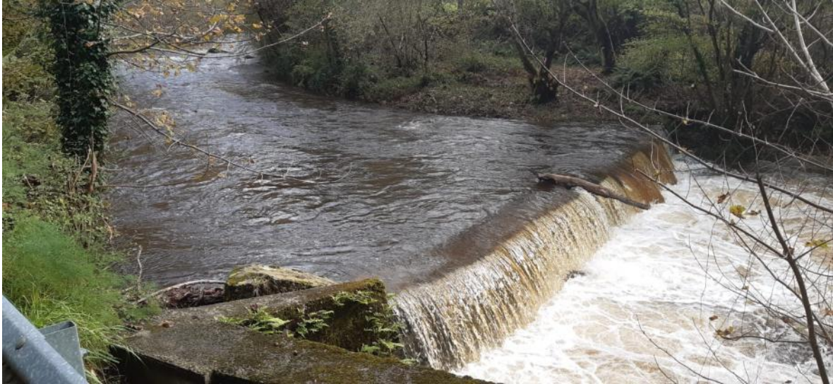
Antes de la retirada del azud del río Espinaredo en el Tabayón
