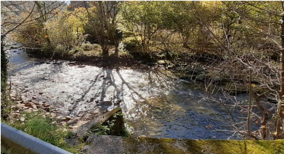
Después de la retirada del azud del río Espinaredo en el Tabayón
