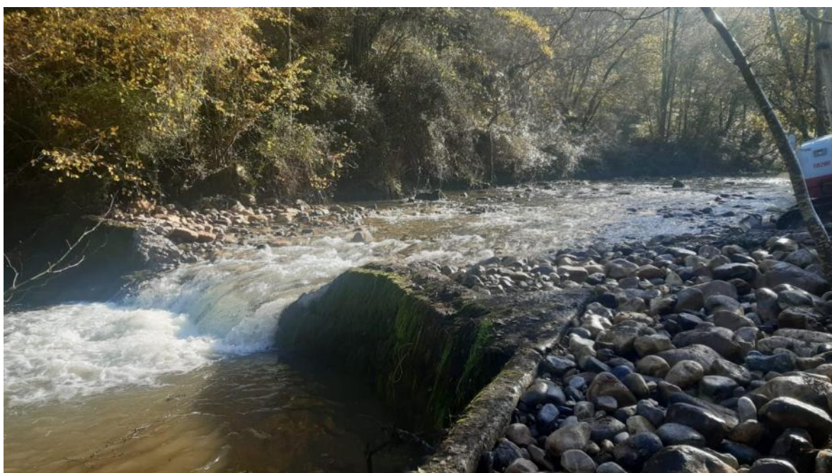
Después de la demolición parcial del azud del río Espinaredo en Lozana
