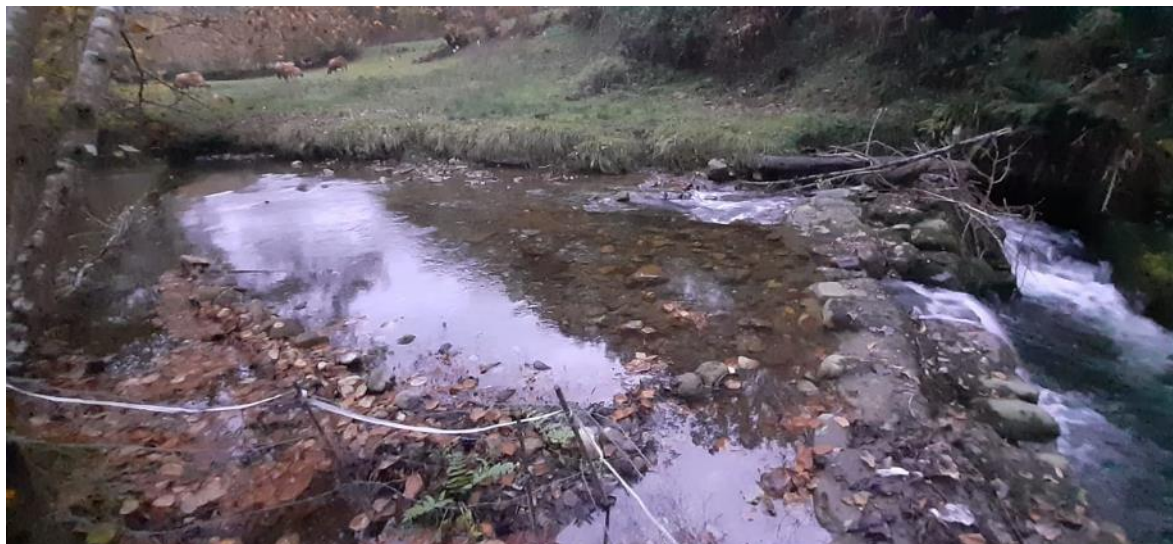
Antes de la retirada del azud del río Tendi en Caldevilla (2)
