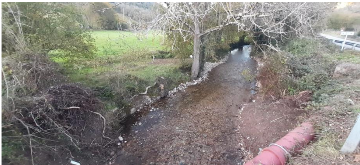
Después de la retirada de azud en río Sama en Traslamuria (1)
