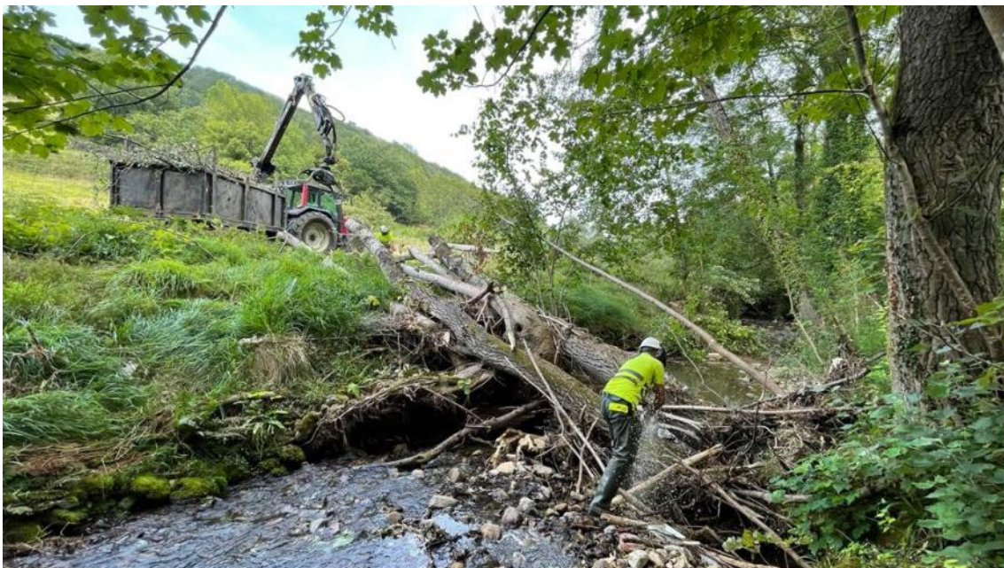
Operario y autocargador retirando estos vegetales
