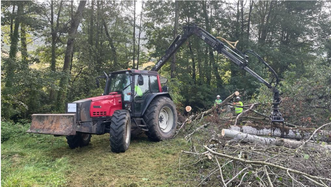
Autocargador retirando restos vegetales.
