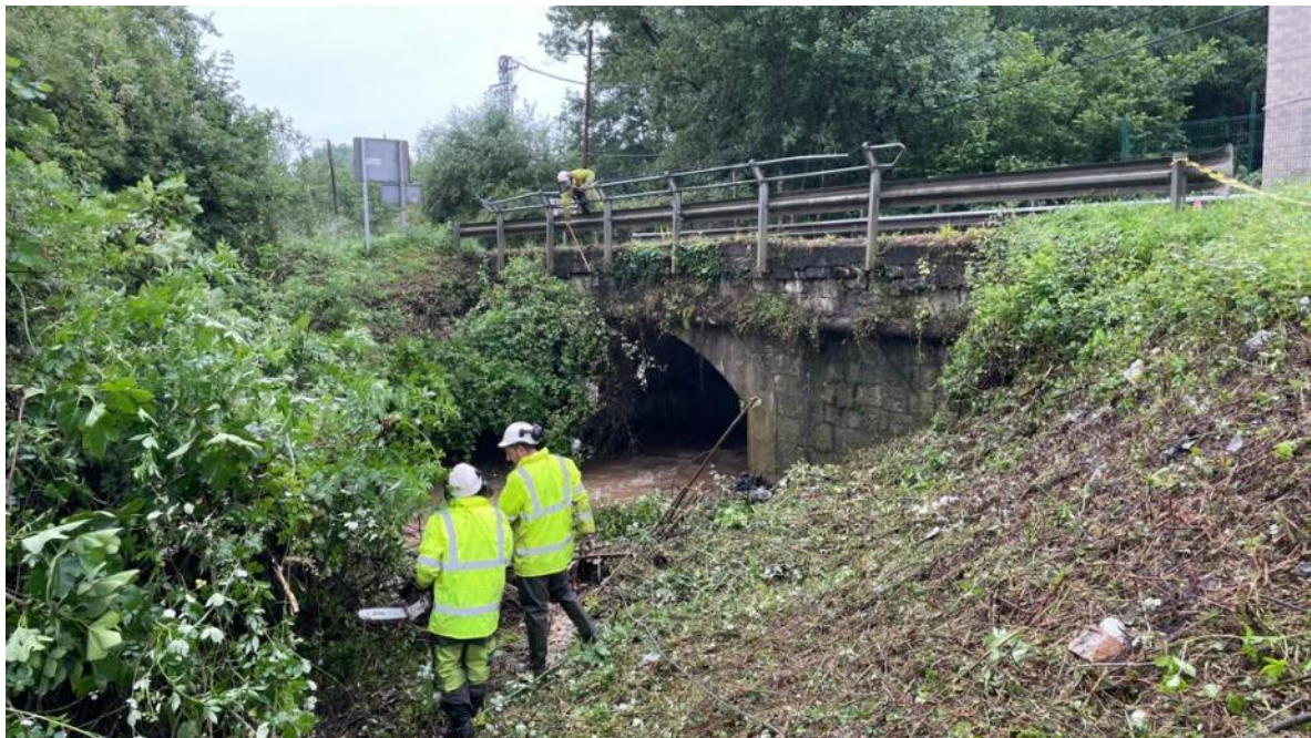
Operario retirando restos vegetales
