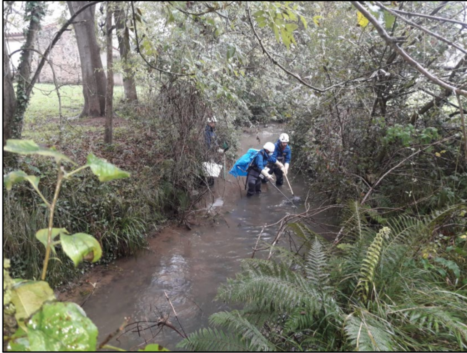
Pesca eléctrica previa a la entrada de la maquinaria
