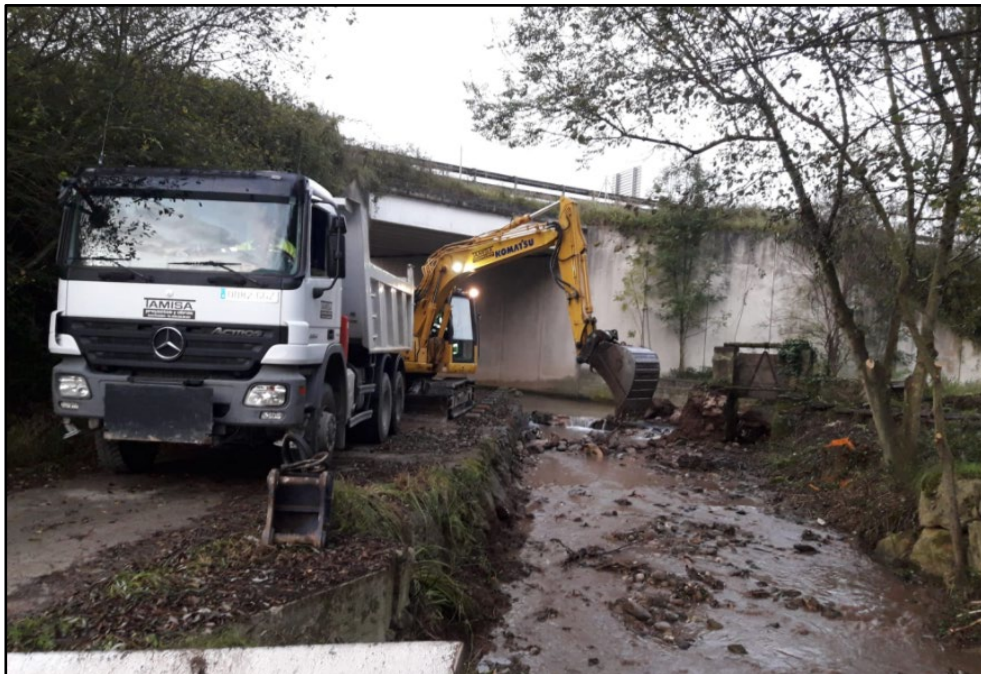
Demolición del azud
