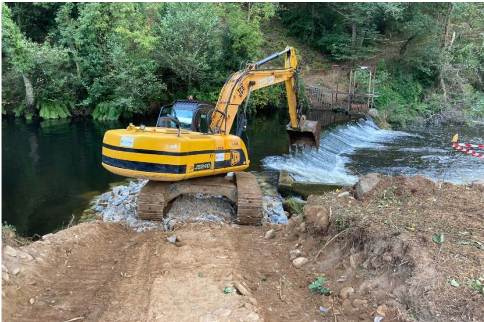
Ejecución de los trabajos
