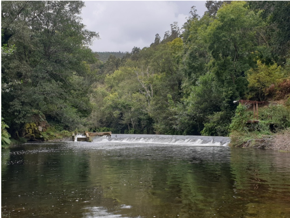
Azud (antes de la actuación)
