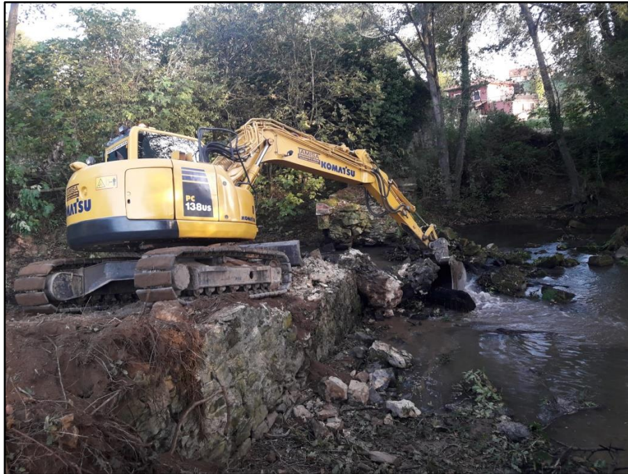
Demolición del azud con maquinaria
