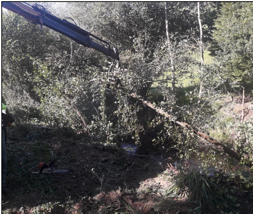
Retirada de árbol caído en mitad del cauce
