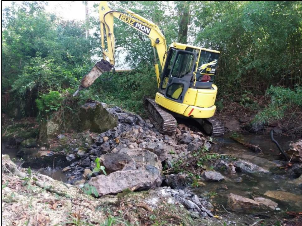
Demolición del azud con maquinaria equipada con martillo
