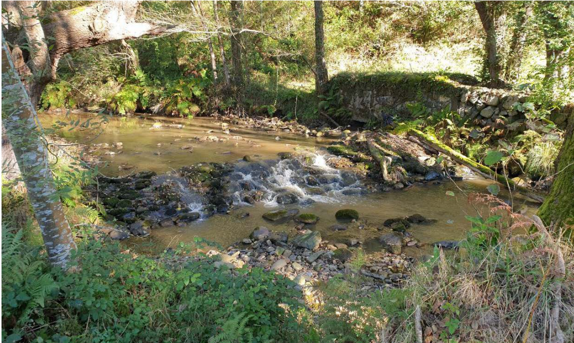
Azudes en cabecera del Porcía Obs-3 antes de la actuación
