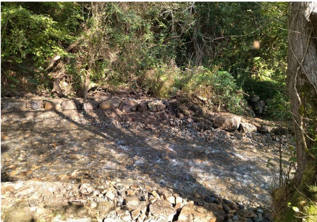
Azud en río El Mazo Obs-10 después de la actuación
