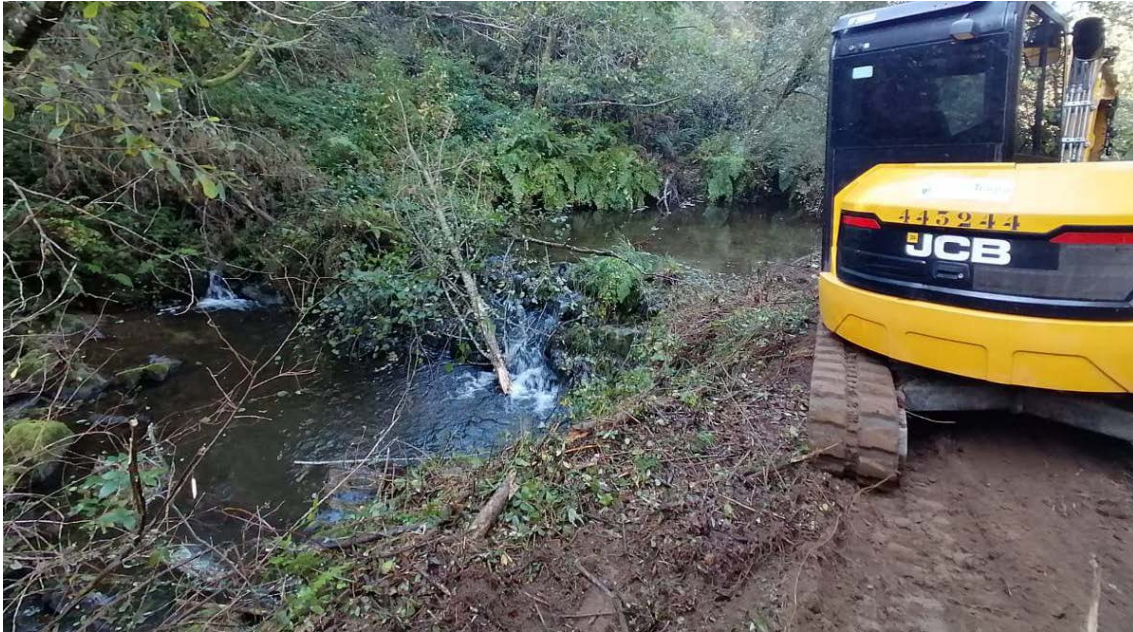
Azud en río Cabo Obs-7 antes de la actuación
