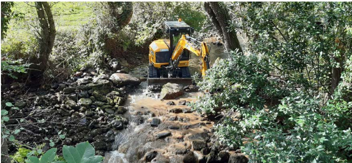
Azud en río El Mazo Obs-11 durante la actuación
