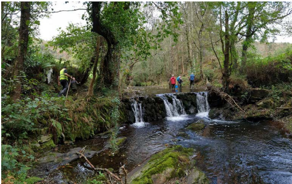
Azudes en cabecera del Porcía Obs-2 antes de la actuación
