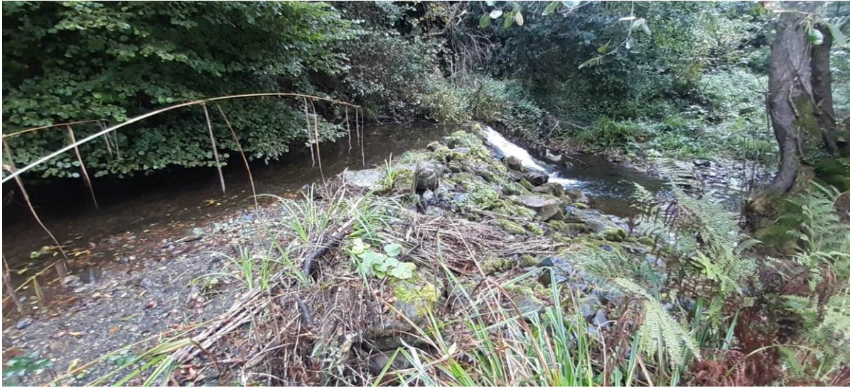
Azud en río El Mazo Obs-10 antes de la actuación
