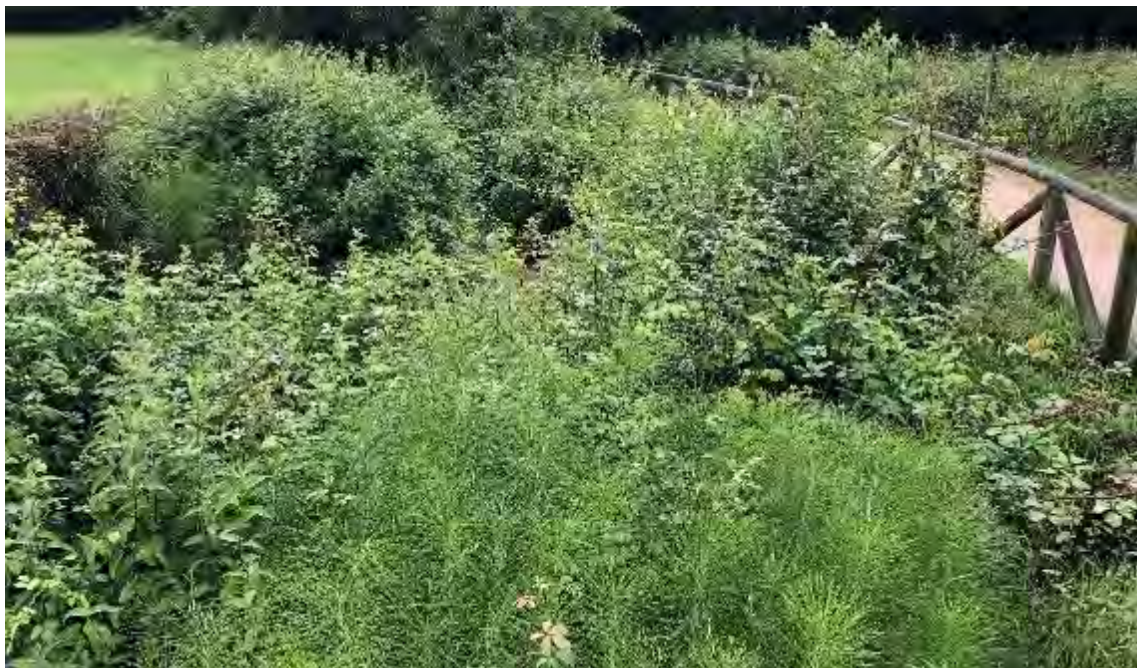
Ramaje intensivo que obstruye el cauce en el arroyo de la Vega en Aroles
