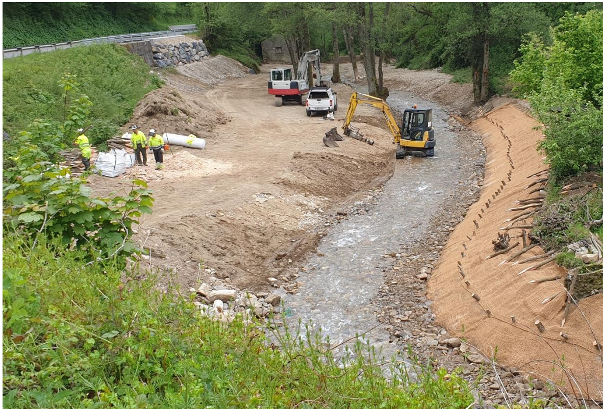
Durante la actuación (tramo 2)
