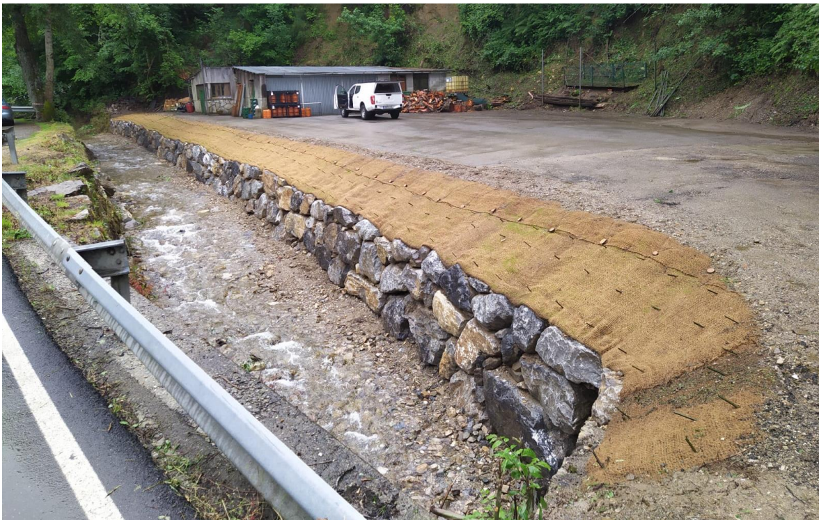
Después de la actuación vista hacia aguas arriba (tramo 1)
