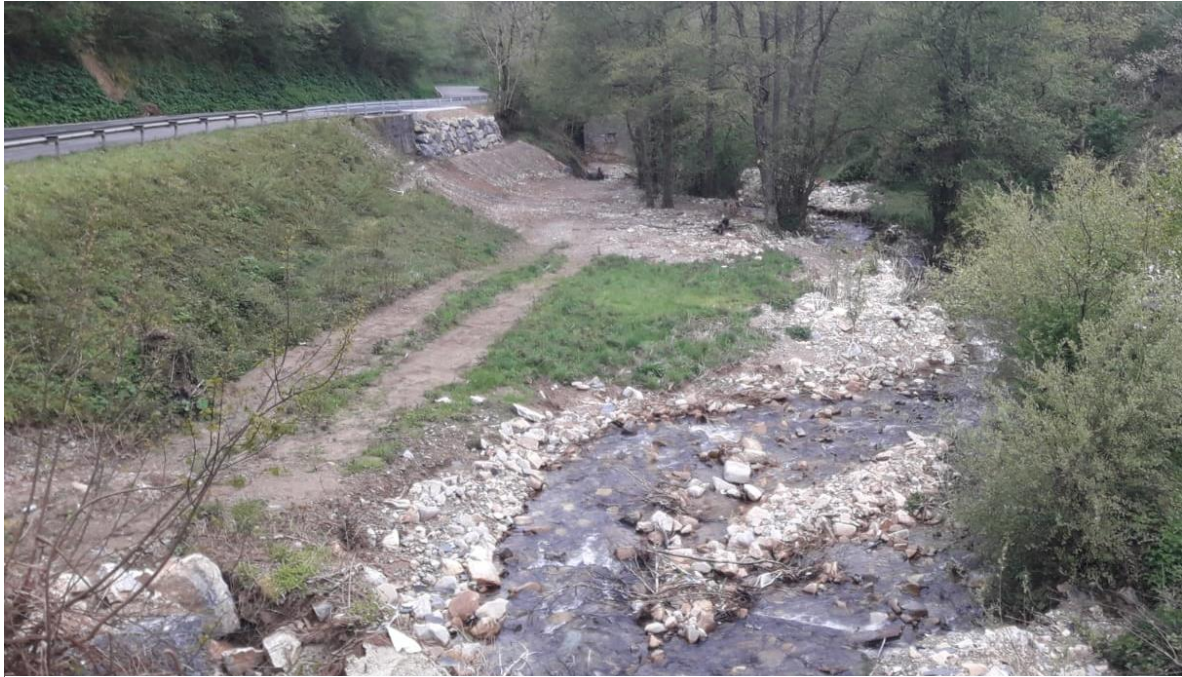
Antes de la actuación (tramo 2)
