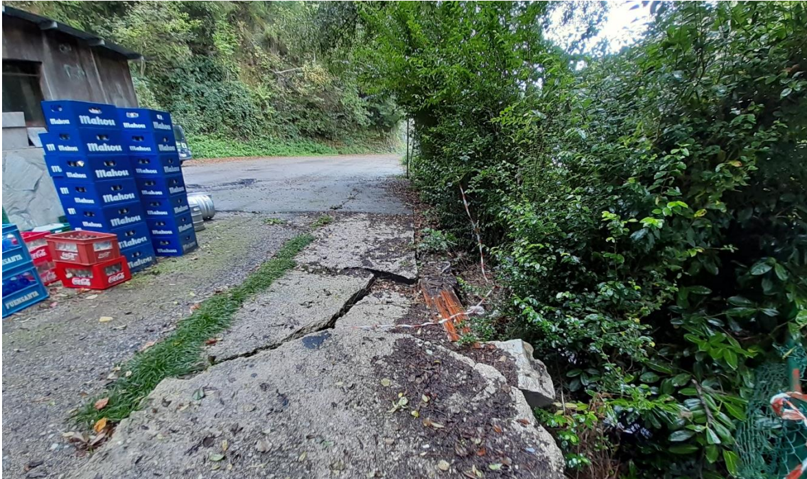
Margen izquierda antes de la actuación vista hacia aguas abajo (tramo 1)
