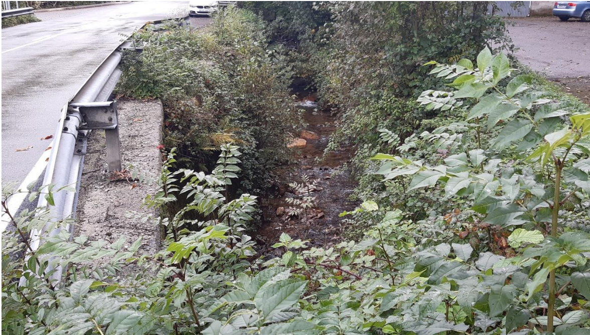
Antes de la actuación vista hacia aguas arriba (tramo 1)
