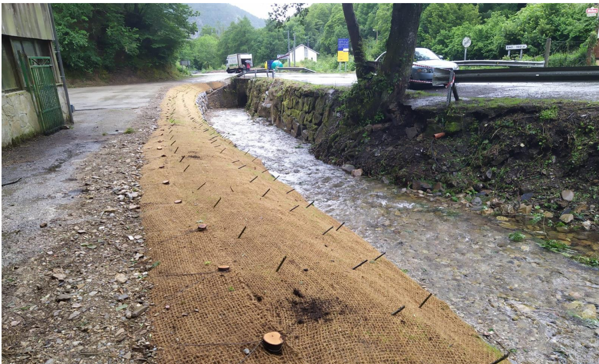
Después de la actuación vista hacia aguas abajo (tramo 1)
