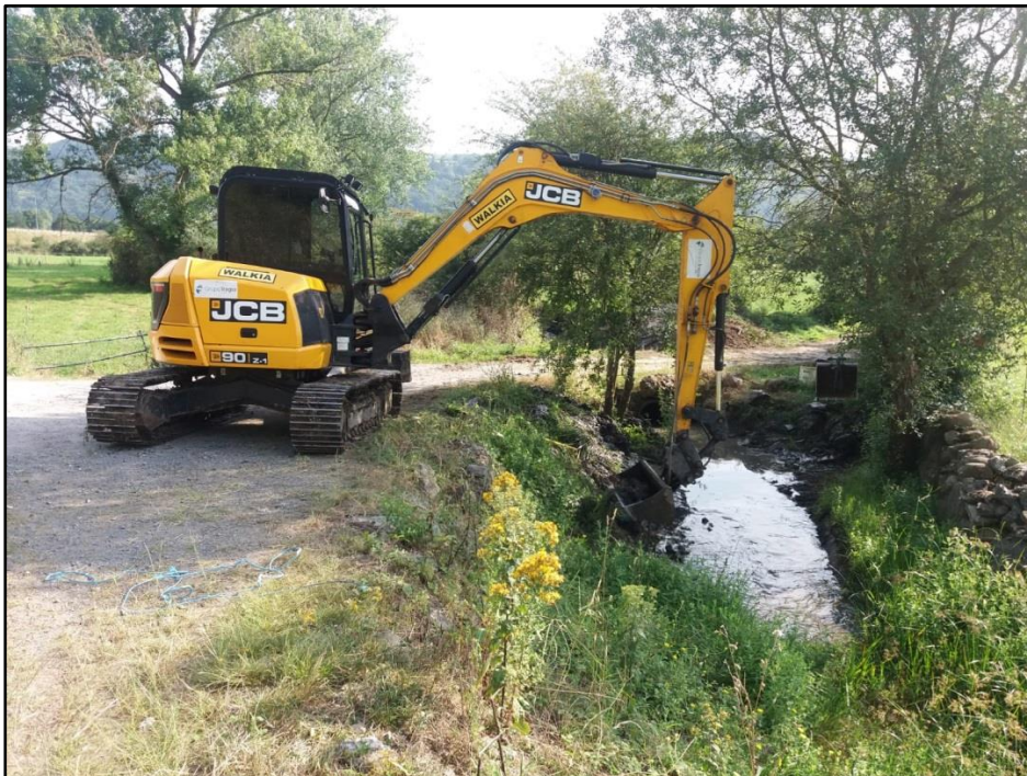
Retirada de sedimentos
