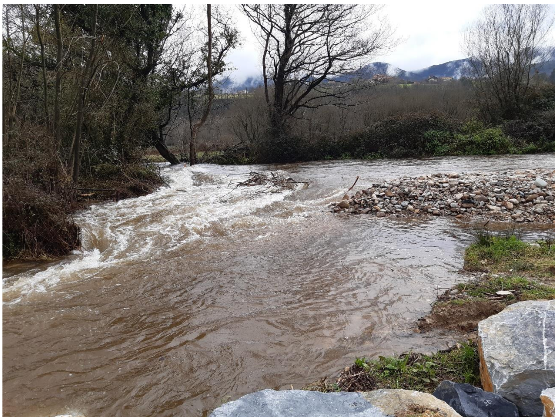
Zona de recuperación ambiental de la margen izquierda
