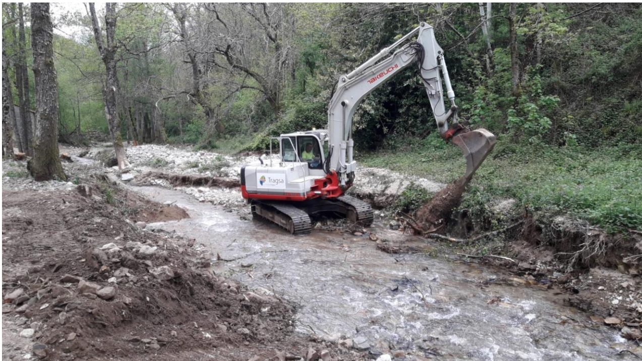
Apertura de la sección del cauce
