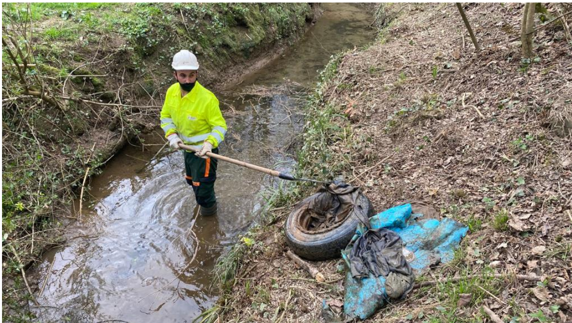
Operario sacando restos antrópicos
