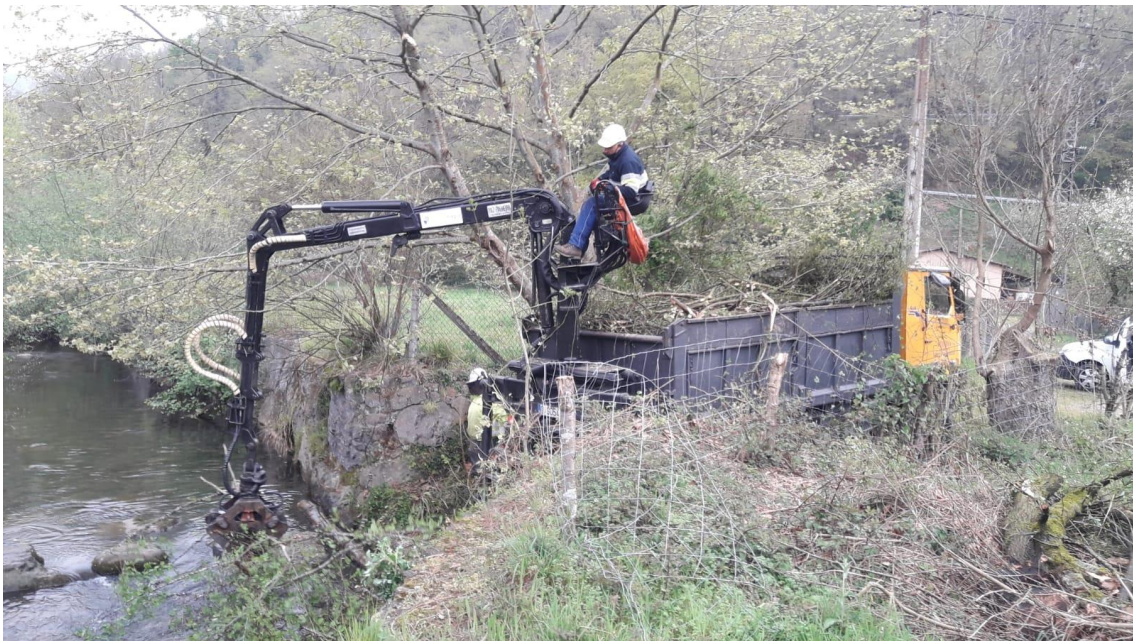
Retirada de madera del río
