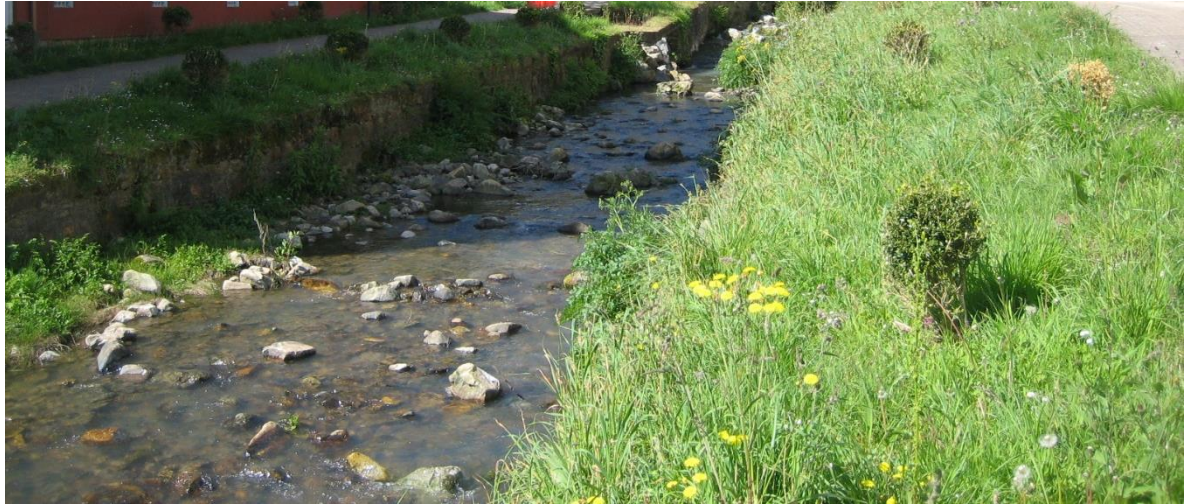
Zona en la que se retirará sedimento en margen izquierda
