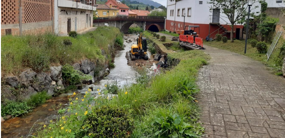
Mini-retro comenzando los trabajos
