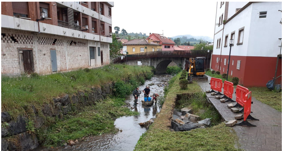
Operarios ejecutando la pesca eléctrica
