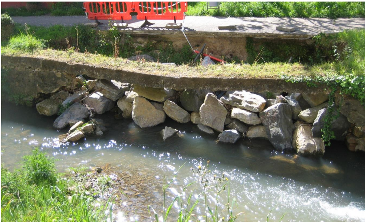
Derrumbamiento margen derecha del paseo fluvial
