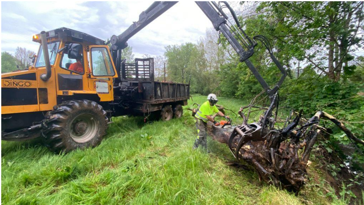
Operario troceando restos vegetales para su posterior gestión
